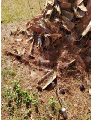
Foto de anclaje 3
