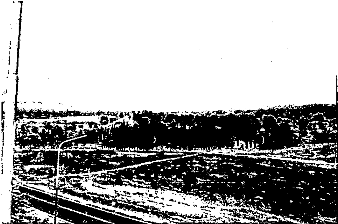
Vistas del Area de la Villa Turística. Sector a desarrollar con urbanización y servicios.
