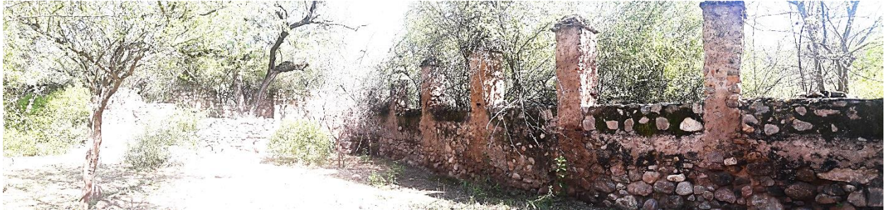
Imagen 30: columnas del patio correspondiente a las estructuras Jesuita
