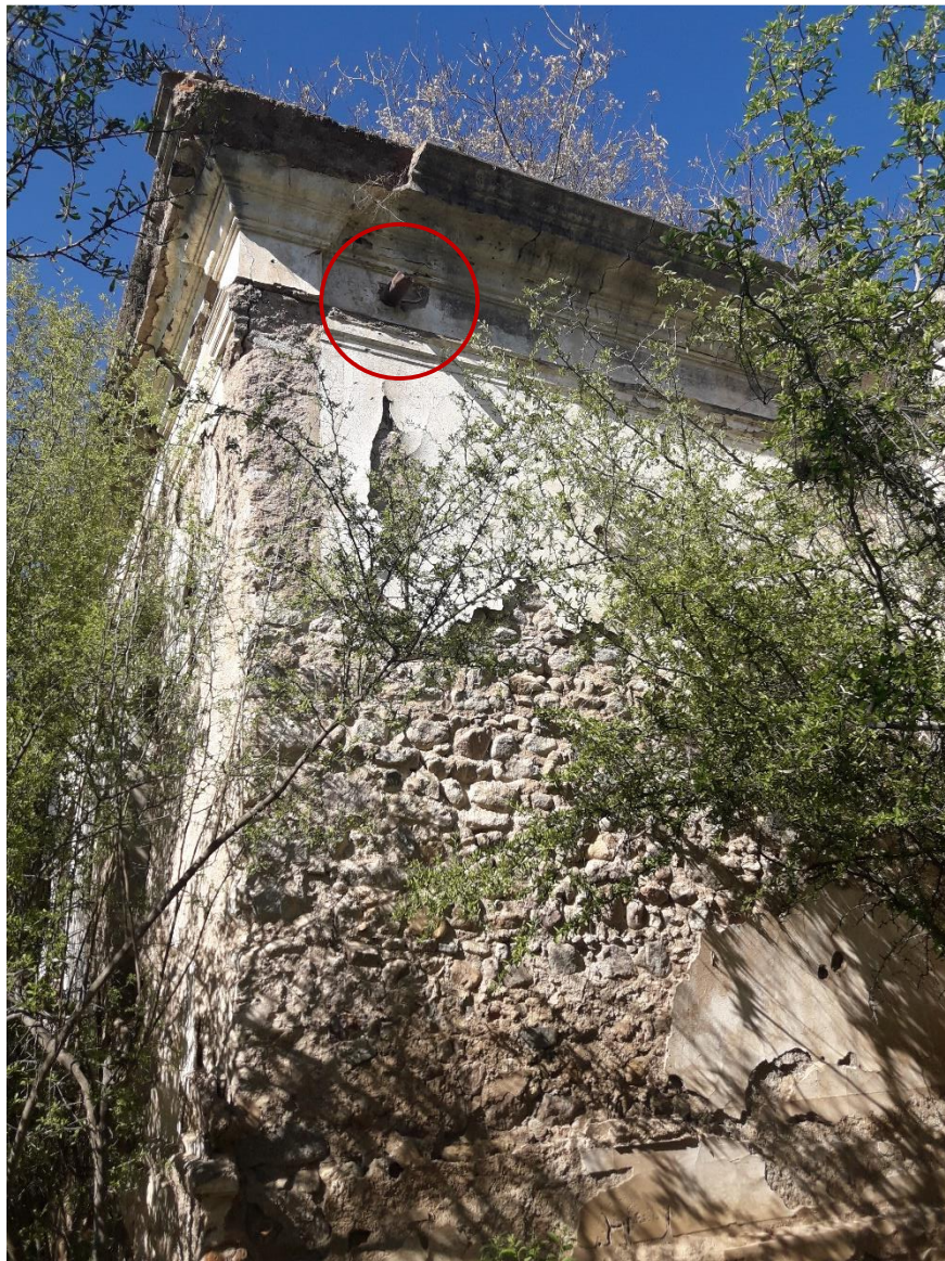
Imagen 25: vista de unas de las gárgolas de drenaje que aún se conserva
