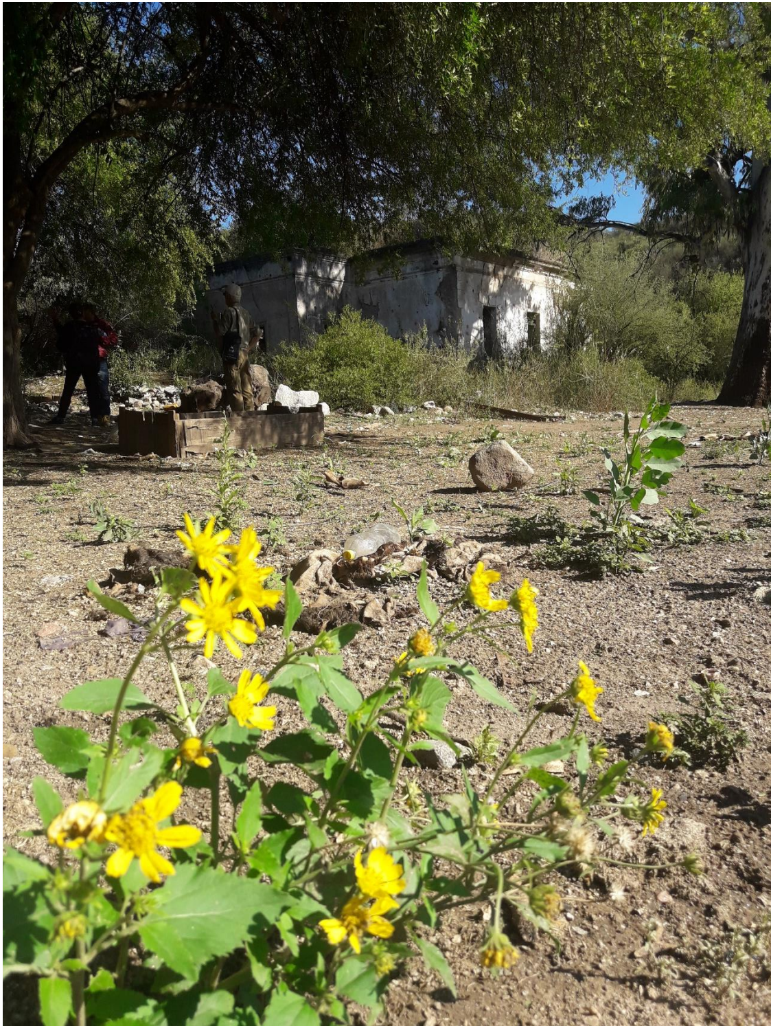
Imagen 39: vista del frente de la Casona del Siglo XIX
