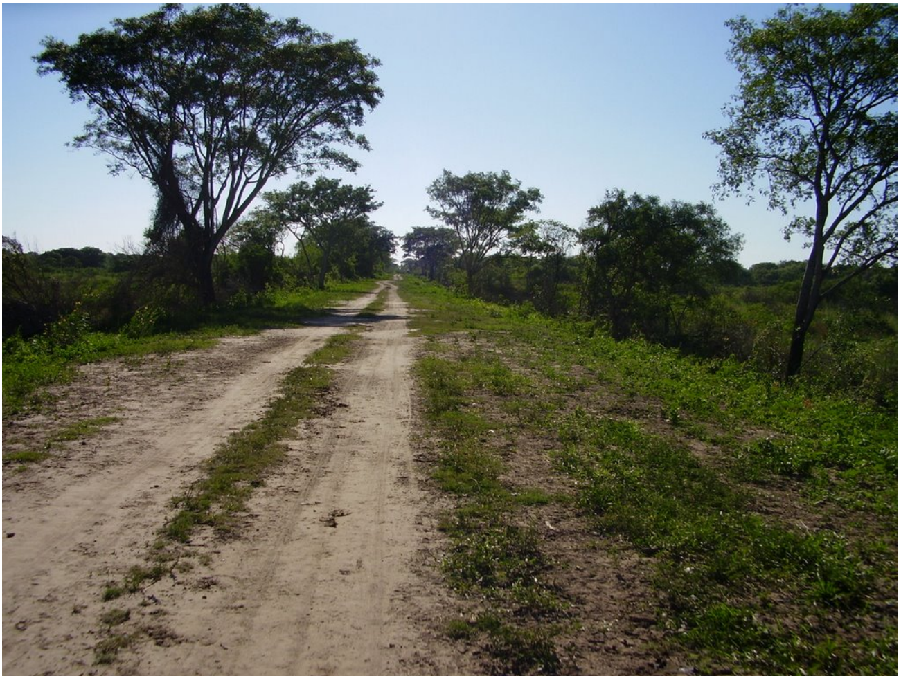
Figura 3-4 – Terraplén RP32 en zona entre el Paraná Miní y el Río Paraná (imagen obtenida de Google Earth)
