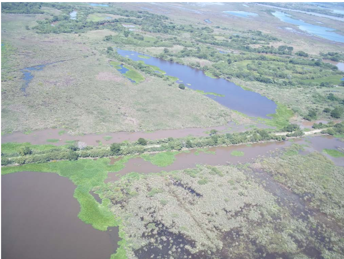
Figura 3-3 – Vista general del estado del terraplén en la situación actual
