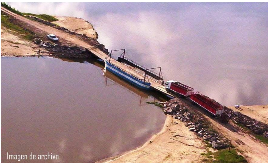
Figura 3-2 – Puente flotante en operación en época de aguas bajas (imagen obtenida de Google Earth)
