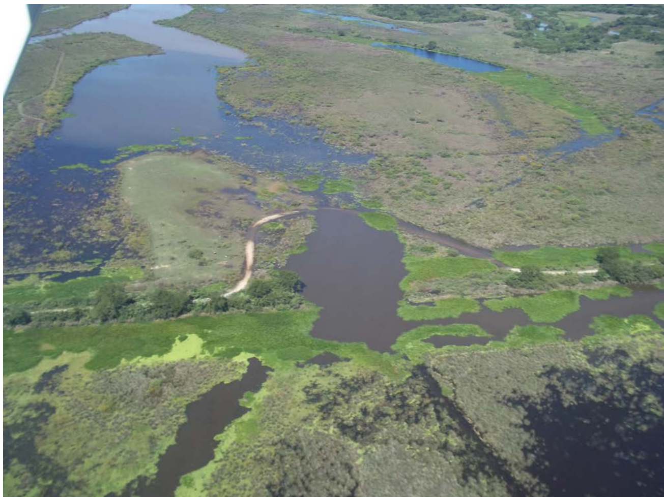
Figura 3-5 – Ejemplo de desvío a bajo nivel construido en puntos donde el terraplén ha sido destruido por las crecidas
