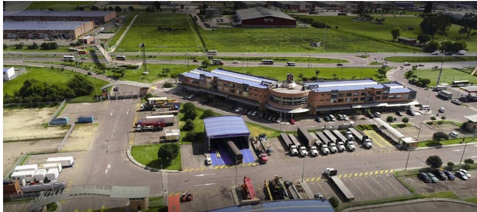
Imagen IV-37: Vista aérea de la Terminal terrestre de cargas de Bogotá
