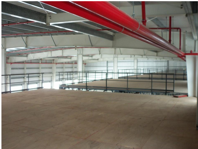
Imagen IV-73: Interior de las naves en el Centro de Transferencias de Cargas
