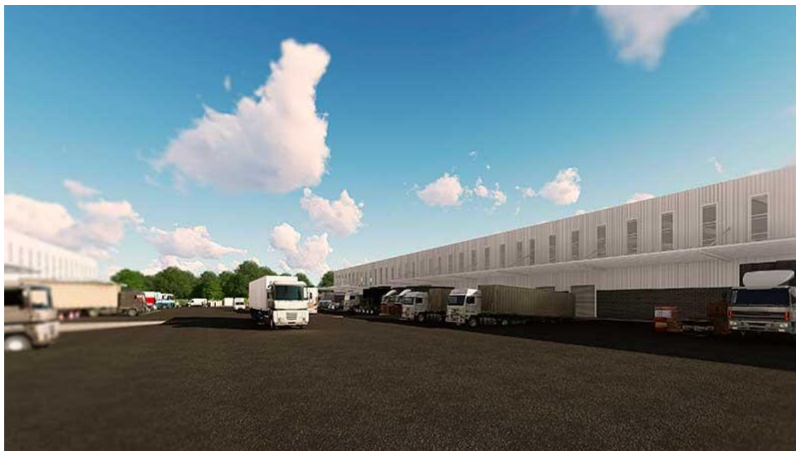
Imagen IV-90: Vista de dársenas del Parque Logístico e Industrial Central Plaza
