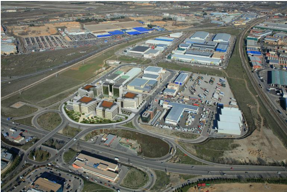
Imagen IV-8: Vista aérea del Centro de Transporte de Coslada
