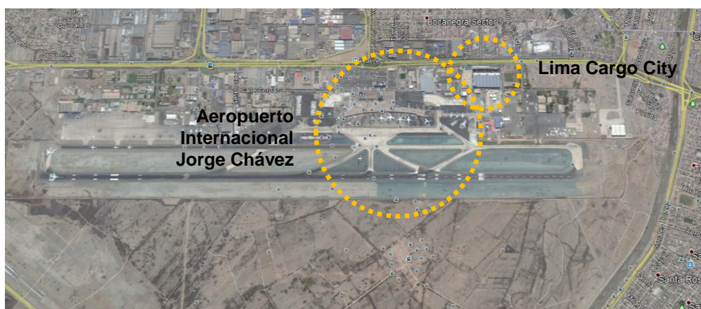
Imagen IV-45: Vista aérea de Lima Cargo City y el Aeropuerto Internacional Jorge Chávez
