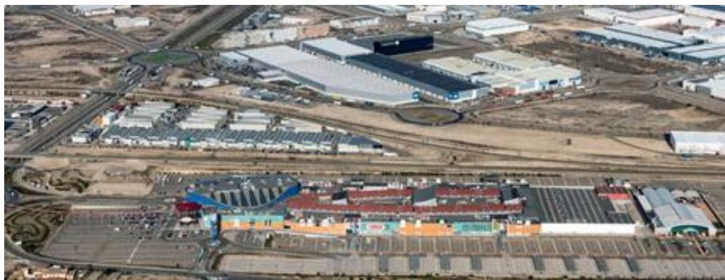
Imagen IV-3: Vista aérea de Plataforma Logística Zaragoza
