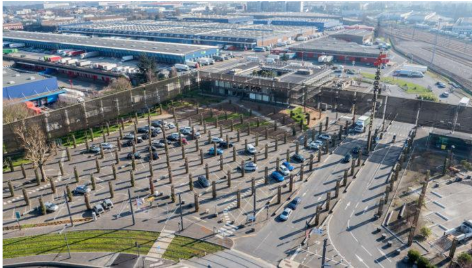
Imagen IV-22: Vista aérea de Sogaris Rungis
