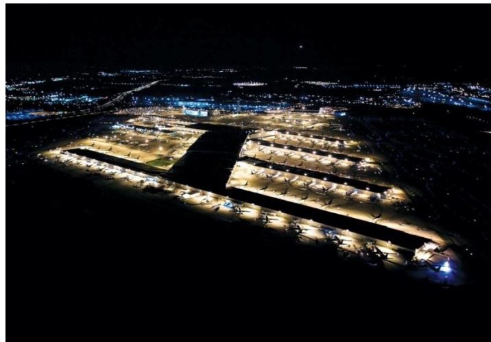
Imagen IV-27: Vista aérea nocturna de Worldport
