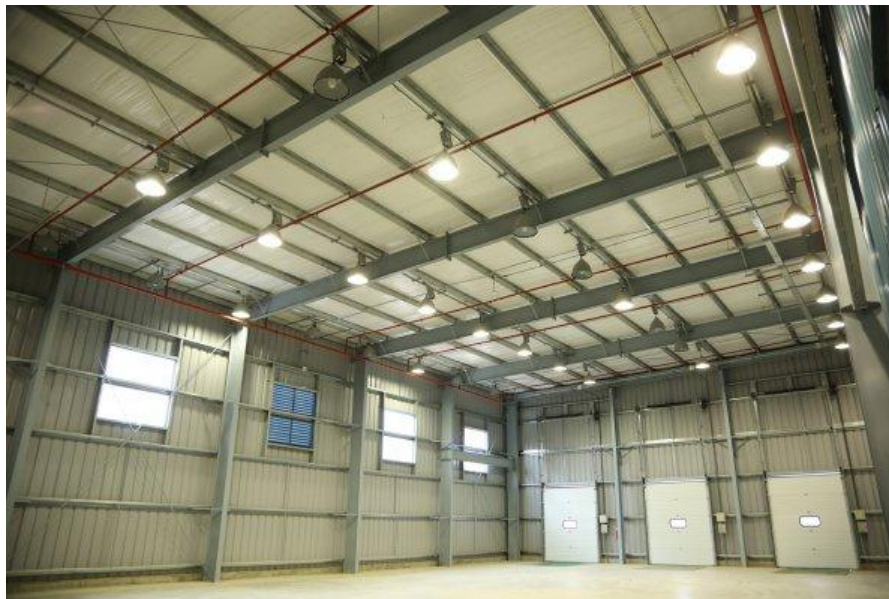
Imagen IV-64: Interior de las naves en Plaza Logística Pilar
