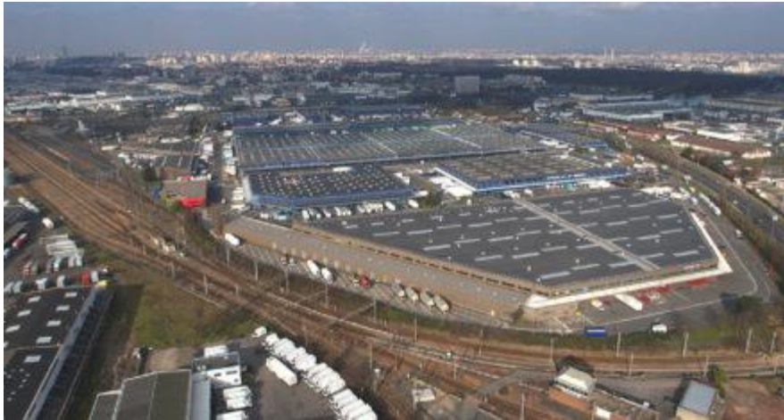
Imagen IV-20: Vista aérea de Sogaris en Rungis
