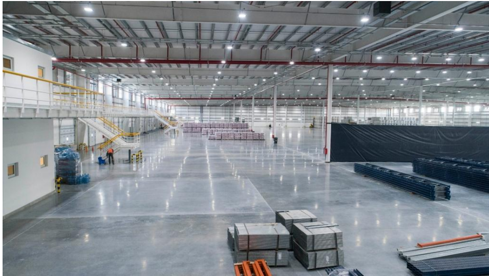
Imagen IV-67: Interior de las naves en Plaza Logística Pilar
