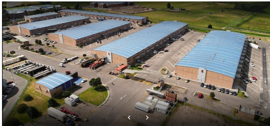
Imagen IV-38: Vista aérea de la Terminal terrestre de cargas de Bogotá
