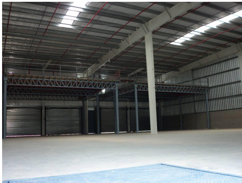
Imagen IV-71: Interior de las dársenas del Centro de Transferencia de Cargas
