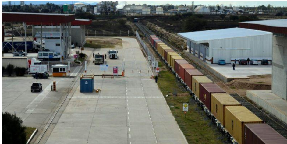
Imagen IV-76: Vista aérea del área ferroviaria de la ZAL San Luis
