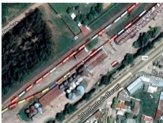
Imagen V-1: Estación de carga de Las Perdices
