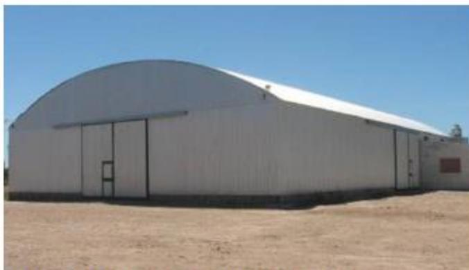
Empaque construido totalmente en chapa galvanizada
