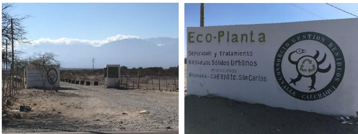
Fig. 77: Acceso al vertedero y a la ecoplanta sobre ruta nacional 40
