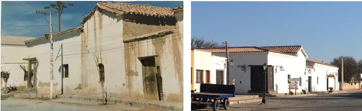
Fig. 95: Edificio del Museo Jallpa Calchaquí. Izq.: previo a su restauración. Der.: en la actualidad.
