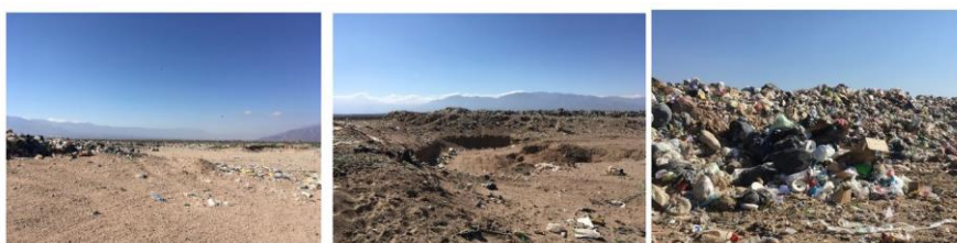
Fig. 81: Relleno sanitario del vertedero regional Calchaquí I. Izq: antigua trinchera cubierta con material árido extraído de la nueva trinchera (derecha) que servirá de relleno sanitario en el corto plazo.
