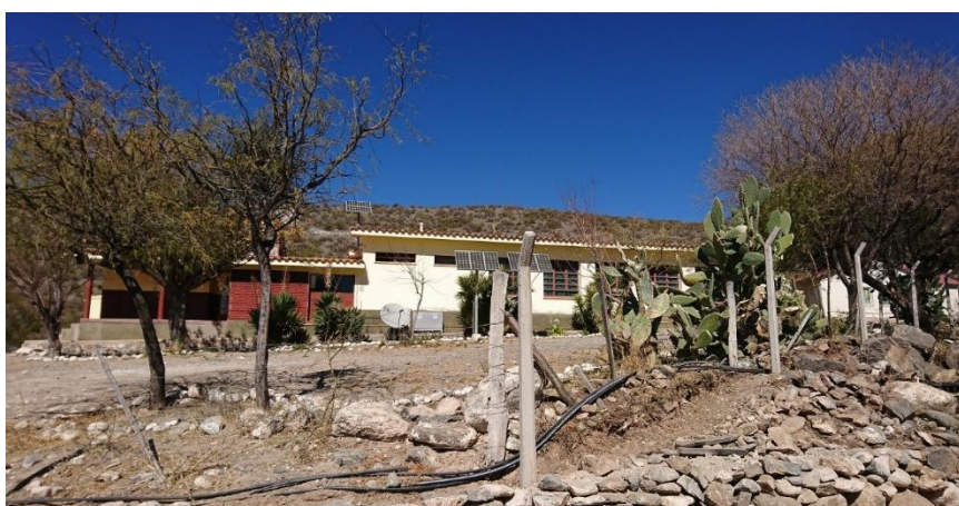
Fig. 72: Paneles solares instalados en San Lucas para abastecimiento de energía eléctrica básica
