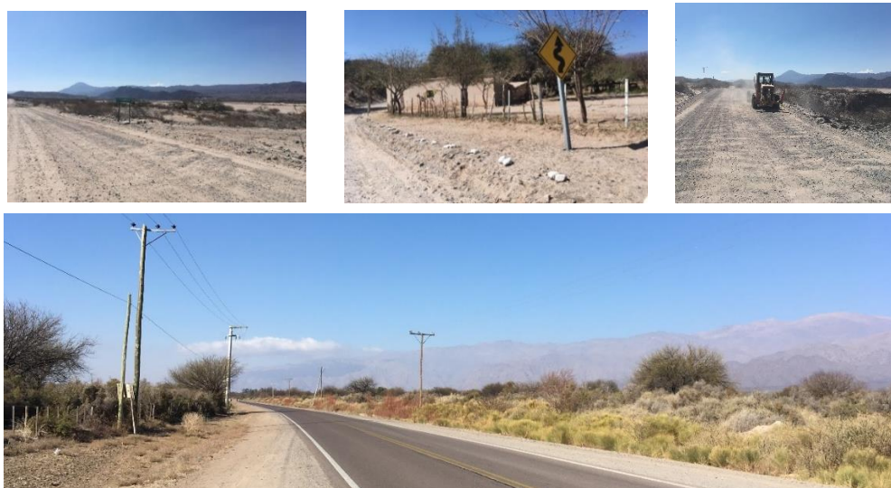
Fig. 84: Arriba: ruta nacional 40 consolidada desde la Dársena hacia el norte, pasando por parajes rurales; maquinaria trabajando en mantenimiento. Abajo: ruta nacional 40 en pavimento flexible desde la Dársena hacia el sur.
