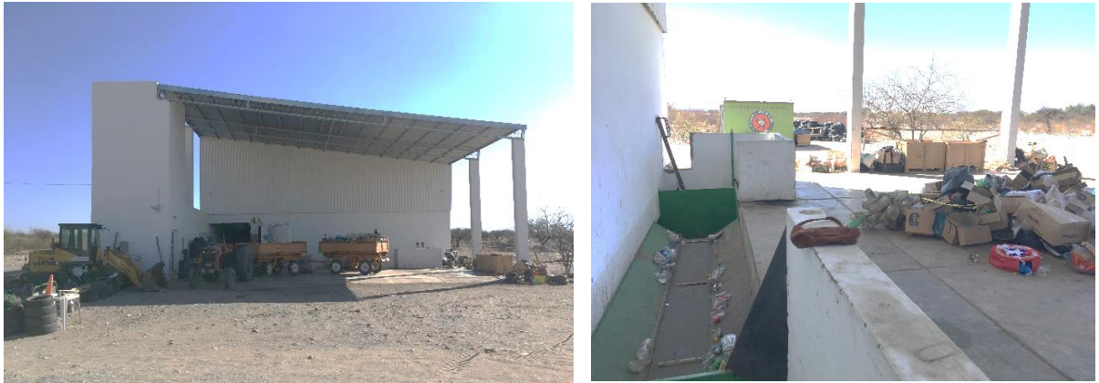
Fig. 78: Áreas de descarga de RSU (izq.) y clasificación (der.) en la ecoplanta
