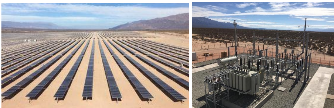
Fig. 73: Planta solar Cafayate, paneles fotovoltaicos y subestación generadora para conectar el parque solar al sistema nacional
