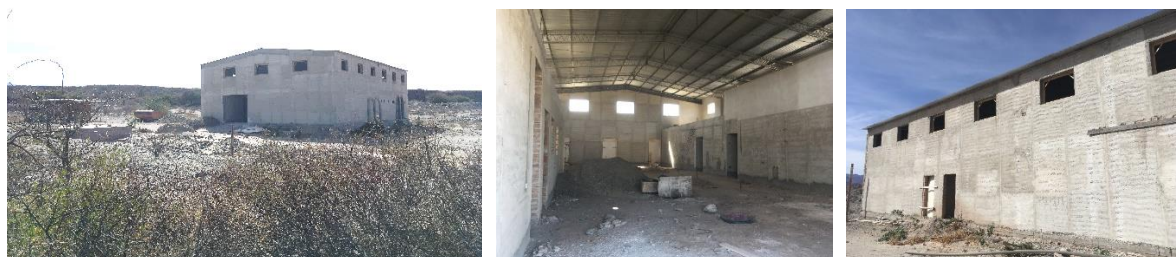
Fig. 112: Construcción del matadero regional, exterior e interior del edificio donde se realizarán las faenas
