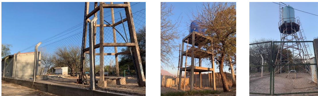
Fig. 66: Infraestructura visible de algunos pozos que captan agua subterránea para distribución domiciliaria. Izq: Pozo 2 y planta de ósmosis inversa en ejecución. Centro: Pozo para los barrios ubicados al sur. Der: pozo en El Barrial.
