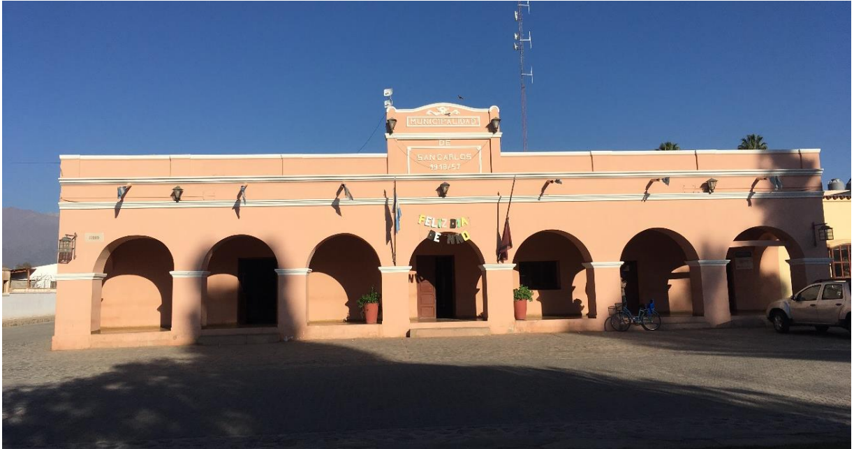
Fig. 93: Fachada del edificio municipal de San Carlos
