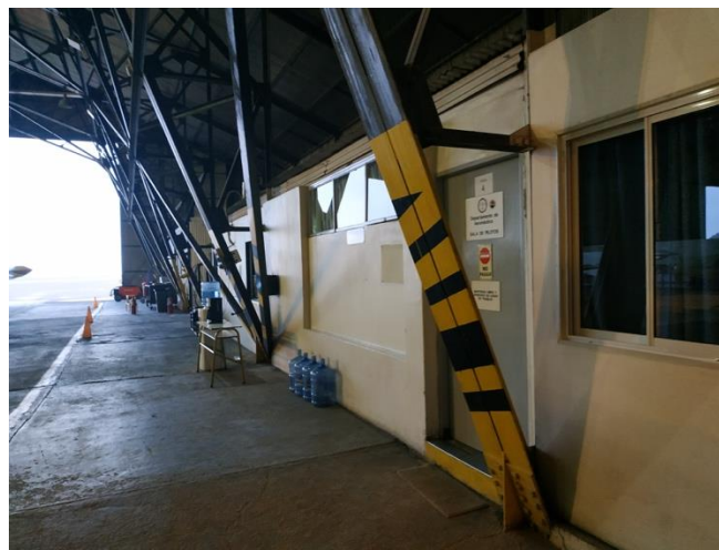
ESTADOS DE TECHOS Y LUMINARIA
