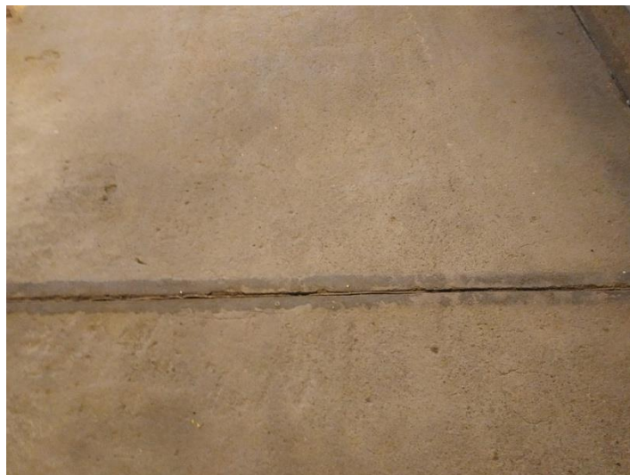
PISOS DEL INTERIOR DEL HANGAR
