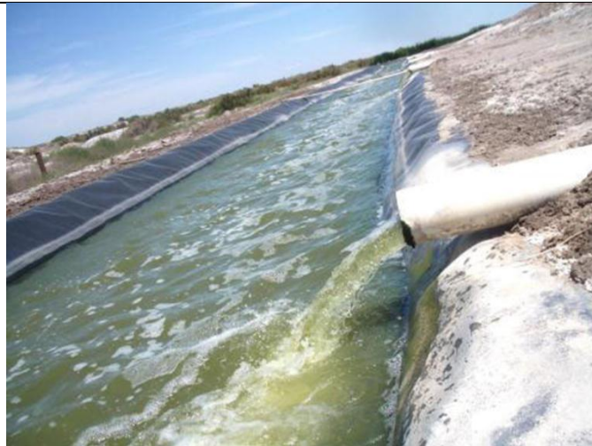
Establecimiento Depurador Campo Espejo
