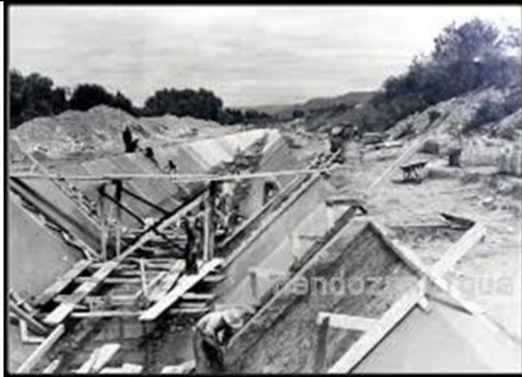
Construcción del Canal matriz del Dique Cipolletti
