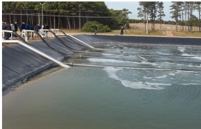
Establecimiento depurador El Paramillo
