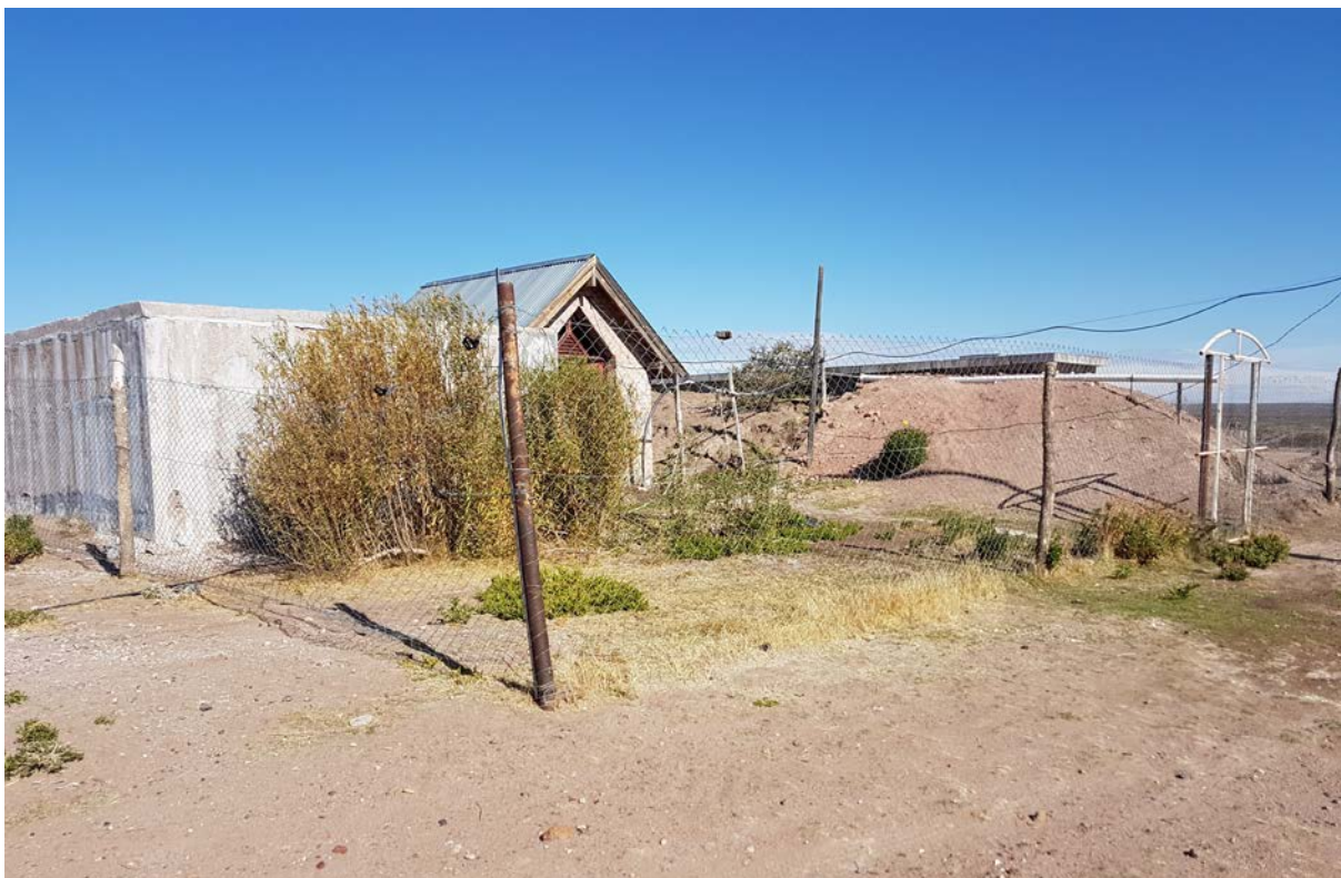
Fotografía 13: Cisterna y bomba de agua
