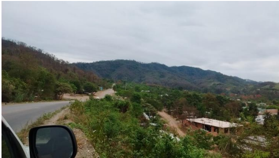
Foto N°---. Viviendas vulnerables a potenciales procesos erosivos y / o gravitacionales.
