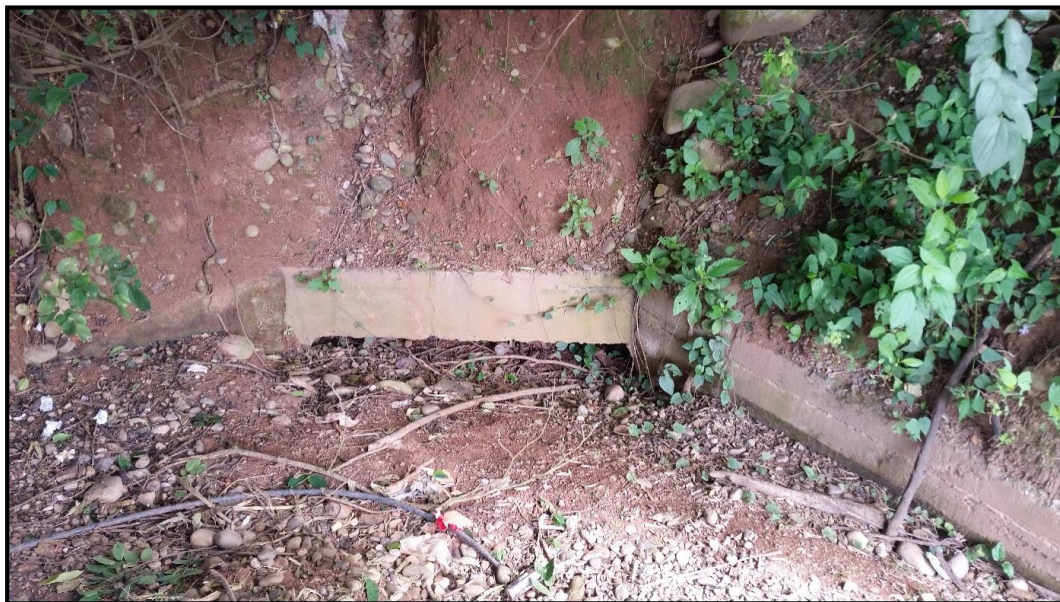
Figura 4. Canal de tormenta casi colmatado en su totalidad.
