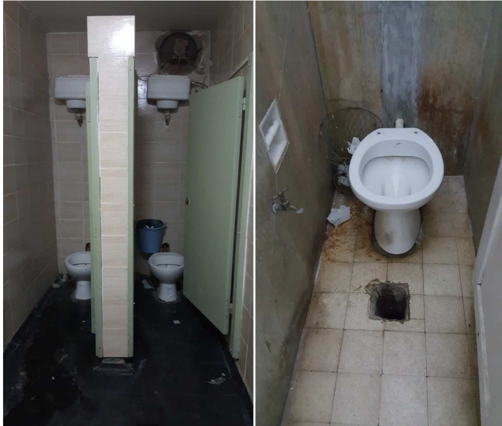
A la izquierda, los sanitarios del Hospital de Villa Ocampo. A la derecha, los de Vera.
