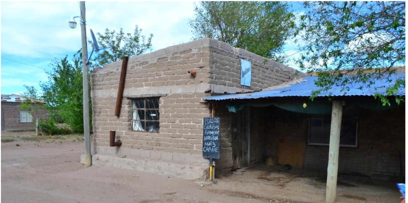
**Ilustración 3: Construcción típica en adobe.**
