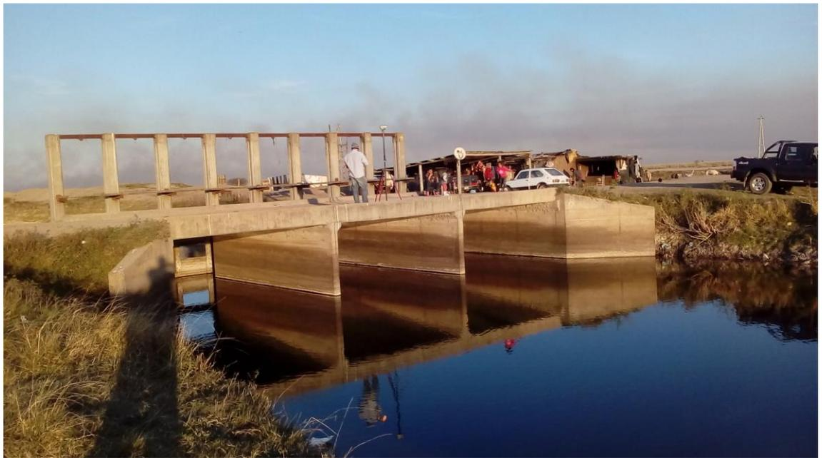
**Figura N° IV.11** Vista de obra de regulación en canal principal Tramo IV-1 R30 -2
