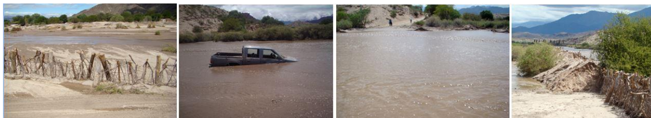
Fig. 20: Crecidas del río Amaicha (2010). Obras de defensa ineficientes, corte de la RP 53 y daños materiales. Fotos: M. Puló
