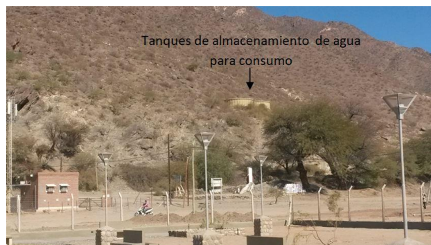
Fig. 54: Tanques de almacenamiento y de agua consumo ubicados en la ladera del cerro Overo
