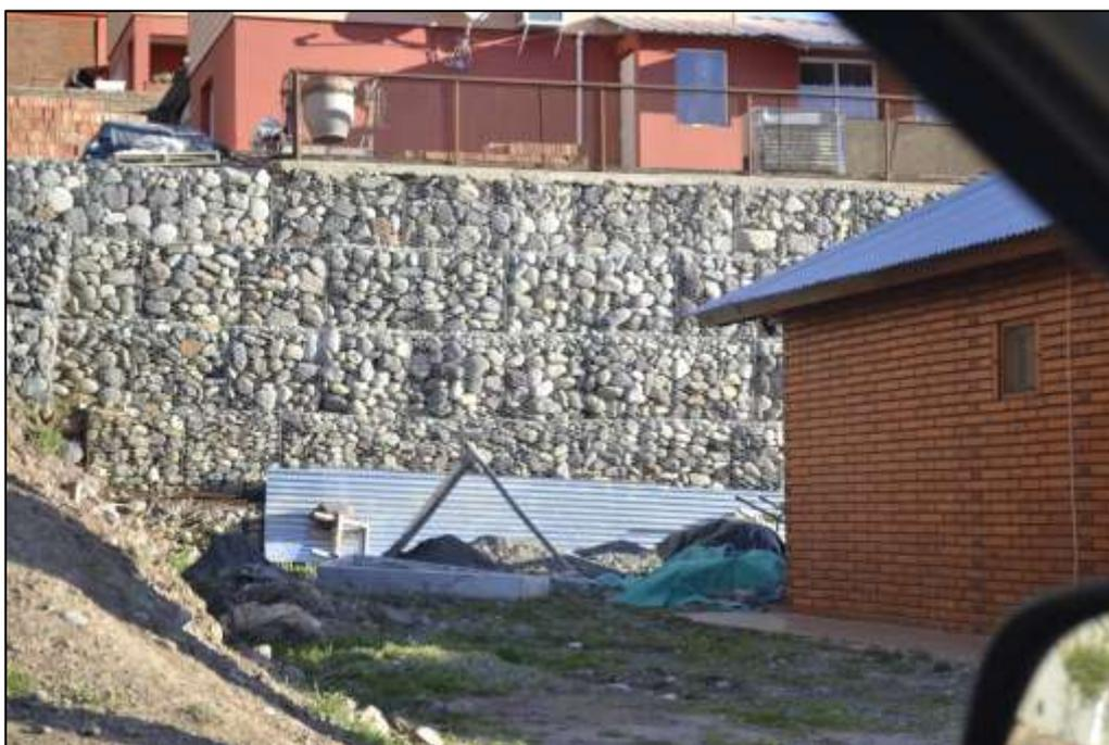
La construcción de barrios en sectores con pendientes fuertes obliga a la construcción de azudes para evitar desmoronamientos de material entre un terreno y otro.
