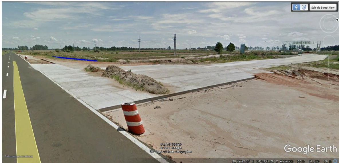
Vista del final de la L.M.T. 33kV, en la entrada al Parque.
