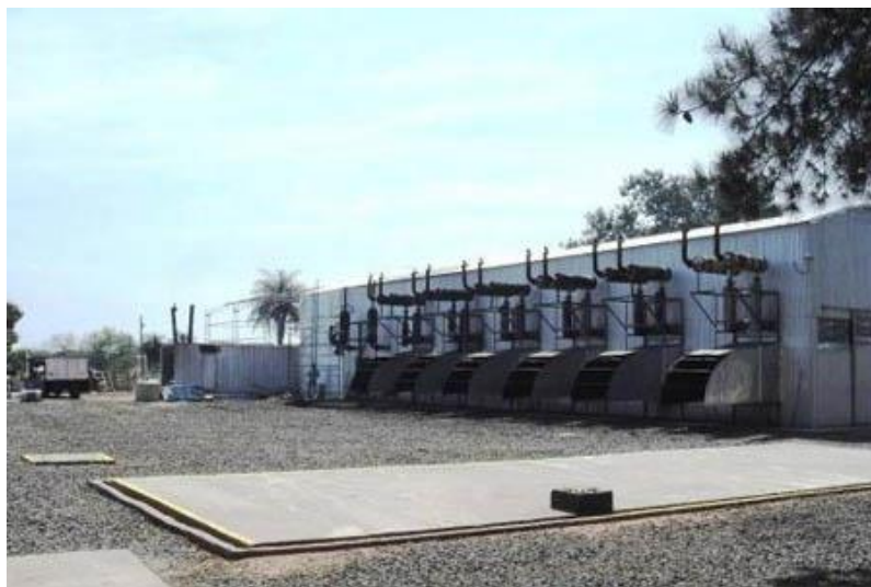
Sistemas de escape de la Central Térmica Santa Rosa
