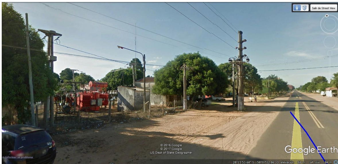
E.T. Santa Rosa 33/13,2kV, sobre Ruta Nacional N° 118.
