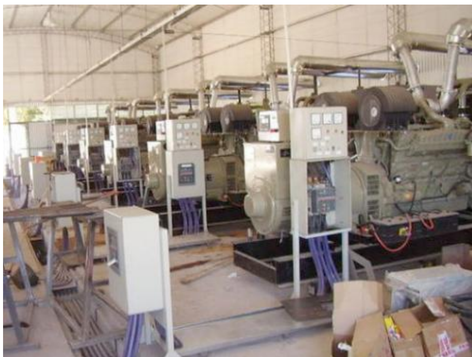
Interior Central Térmica Santa Rosa. Generadores turbo diesel.
