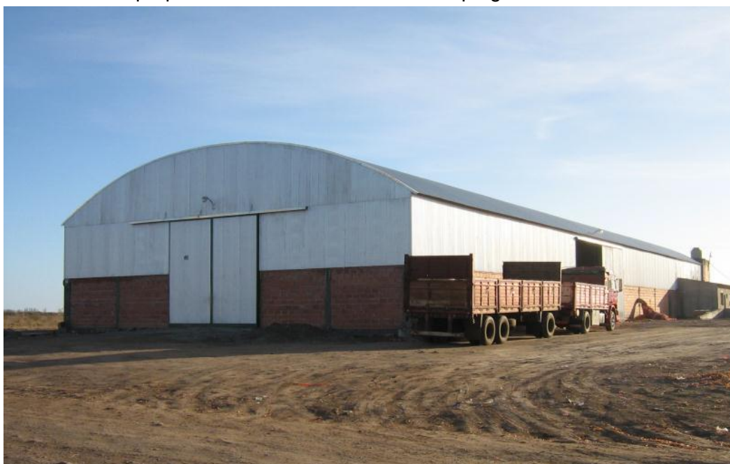
Empaque con paredes de mampostería y chapa galvanizada
