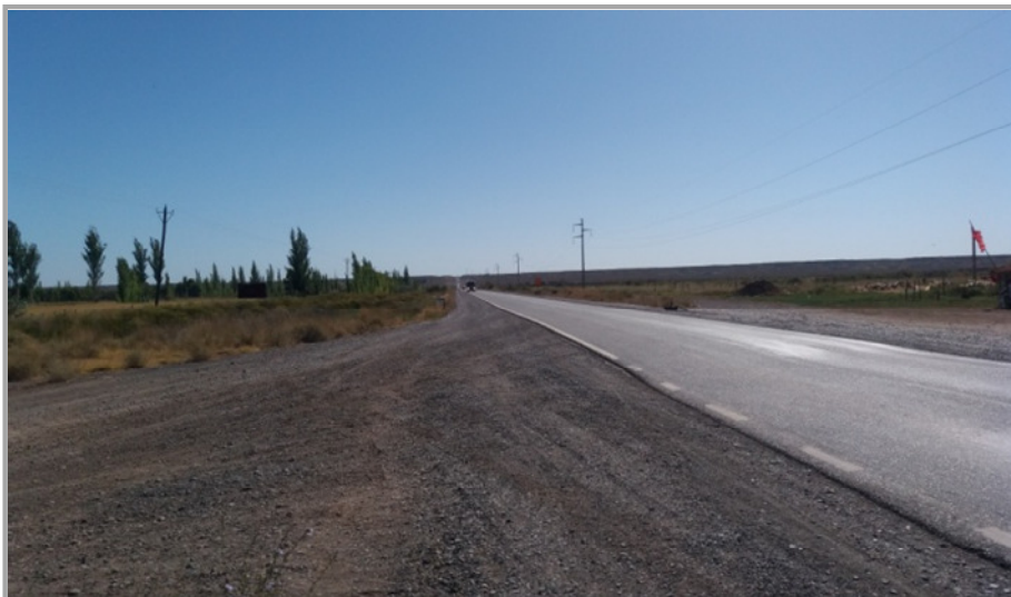
Fotografía 16. Vista de RN 151 en dirección Norte en intersección Calle Rural 15
