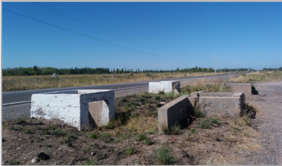
Fotografía 15. Vista de RN 151 en dirección Sur en intersección Calle Rural 15
