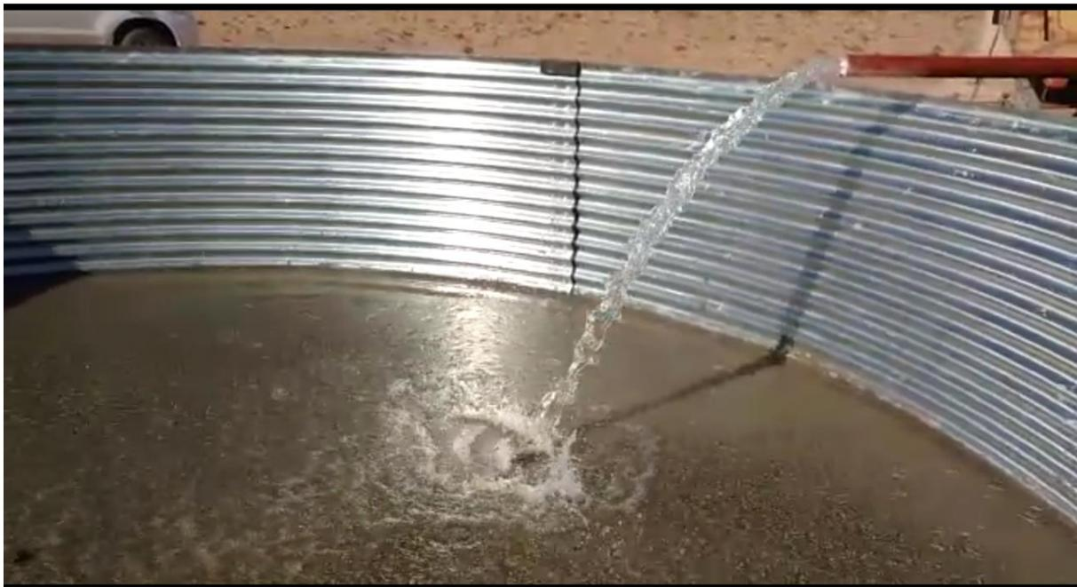
**Fotografía N°2: -Tanque Australiano. Prueba de impermeabilización.**
