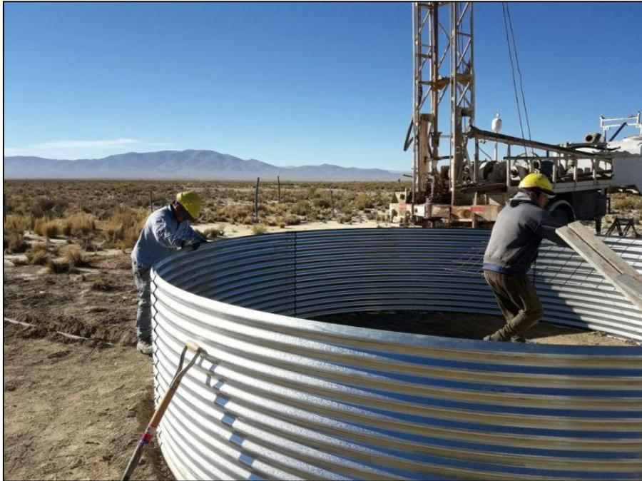
**Fotografía N°3: Construcción del Estanque**
