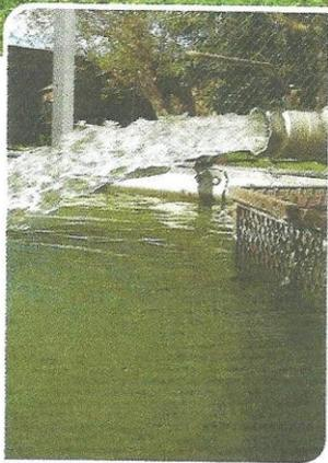
Nuestros **Tanques Australianos FIASA®** son elaborados en chapas de hierro galvanizadas, nuevas, acanaladas, de 1ª calidad, espesor Nº 18 (1,25 mm) de 1,10m. x 3,05 m. Las mismas se envían curvadas y perforadas, con la provisión completa de accesorios para su armado ulterior. Incluye buíones galvanizados con tuercas 5/16" x 3/4, arandelas de cuero y una brida para desagote de 2" acanalada.
