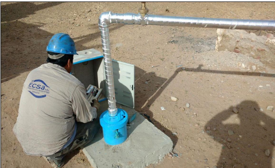
**Fotografía N°4: Colocación de Tablero Eléctrico**
