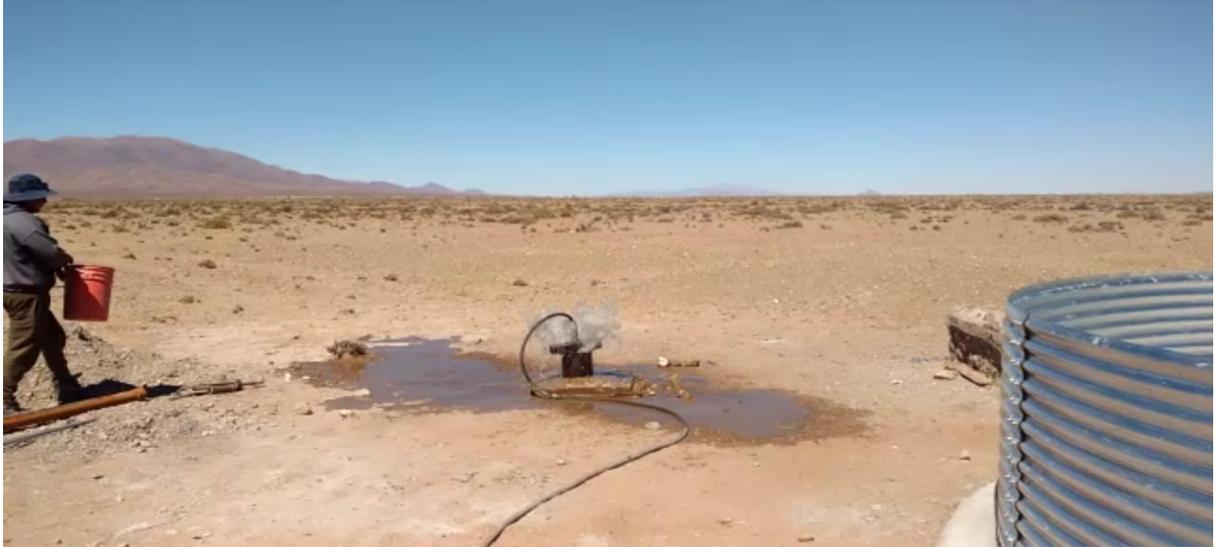
**Fotografía N° 1: Soplado y lavado del pozo Punta de Agua, Cangrejillos.**
