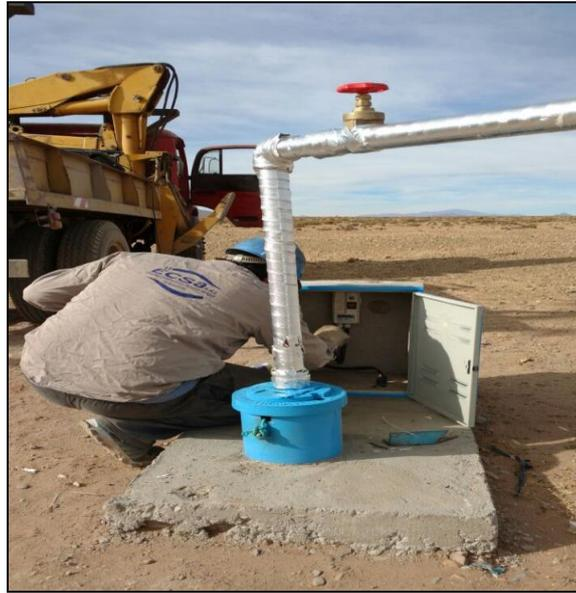
**Fotografía N°3: Colocación del Tablero de Comando**
