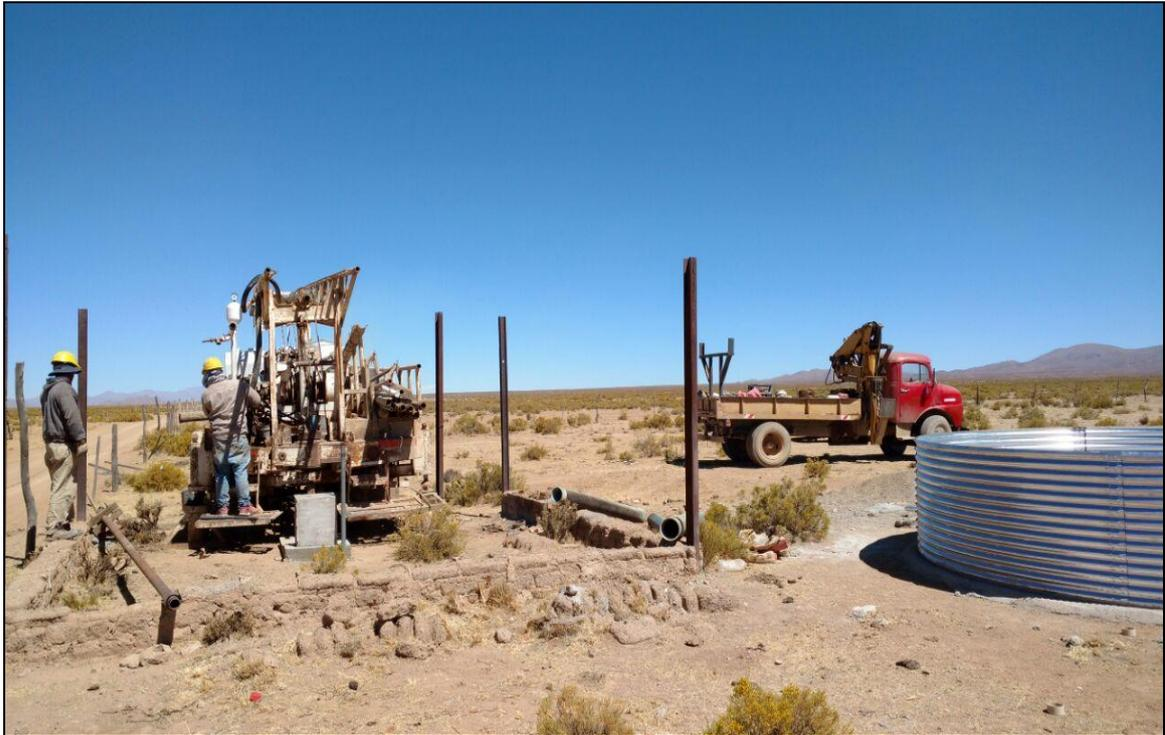
**Fotografía N°6: Desmantelamiento de los equipos después de confirmar la no presencia de Agua.**
