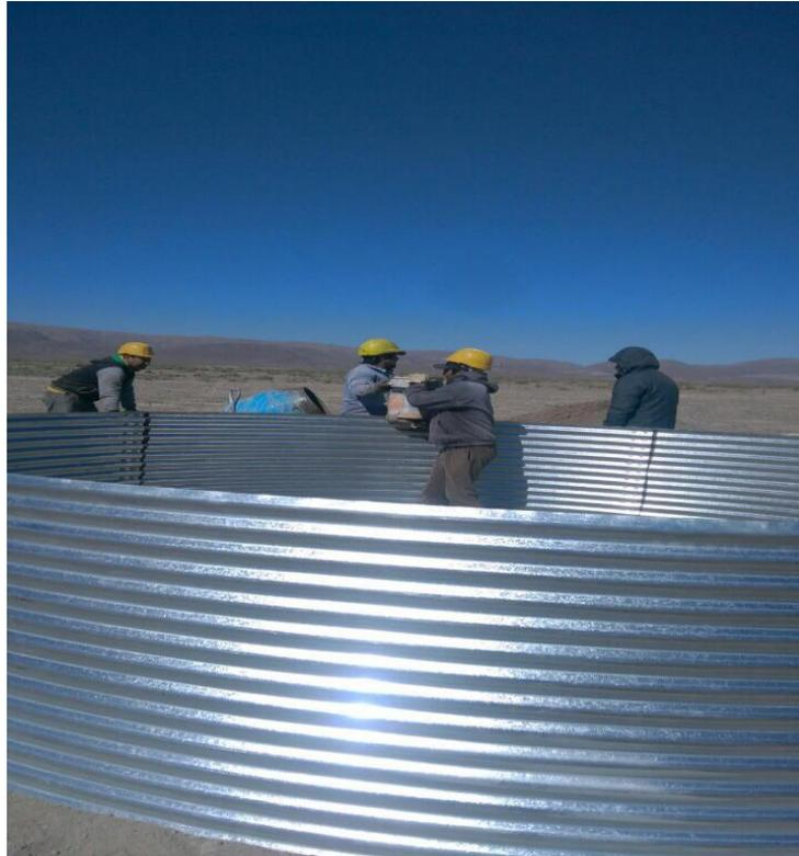
**Foto N° 1: Instalación del Tanque Australiano**
