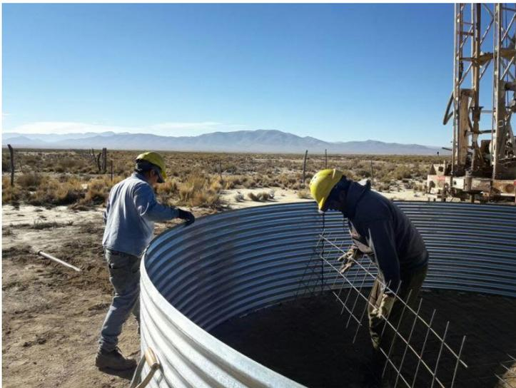
Foto N° 4: Armado del piso de Hormigón.
