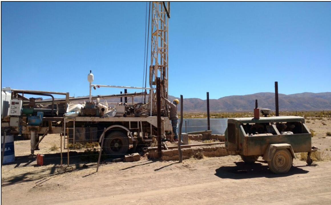
**Fotografía N°5: Instalación de la máquina para realizar disolución de tapón y desarrollo**
