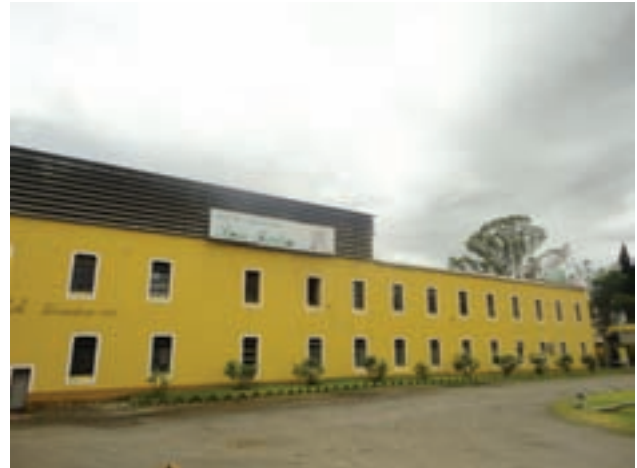
Foto de las instalaciones de época en funcionamiento del Ingenio y Destilería San Isidro. Fundado en 1760 Autor: Gentileza Ingenio San Isidro – Prosal S. A.
