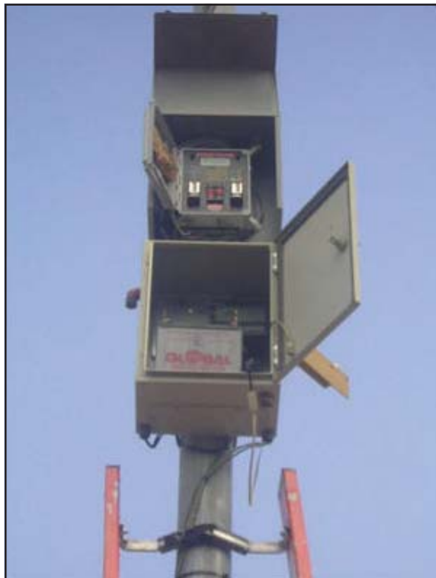
Sistema compuesto NRG para medir a 30 y 20 metros de altura, y Davis para medir a 10 m. (Fuente: CREE).
