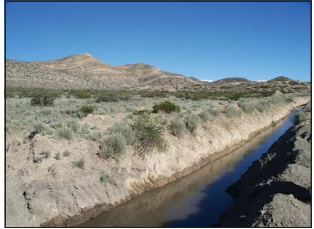
Foto 4. Canal Los Maitenes. Toma sobre el río Curi Leuvú.
