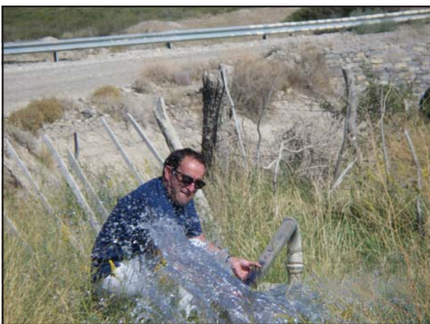
Foto 5. Acueducto en área Taquimilan.
