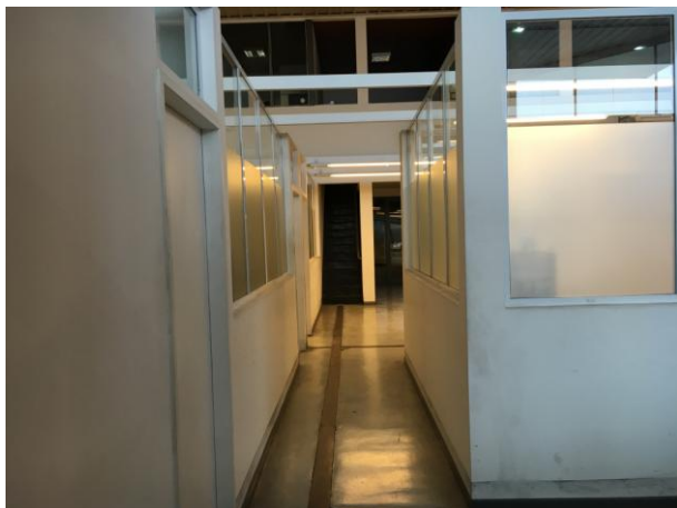
IMAGEN HALL PRIVADO PLANTA BAJA- PISO CEMENTO ALISADO
