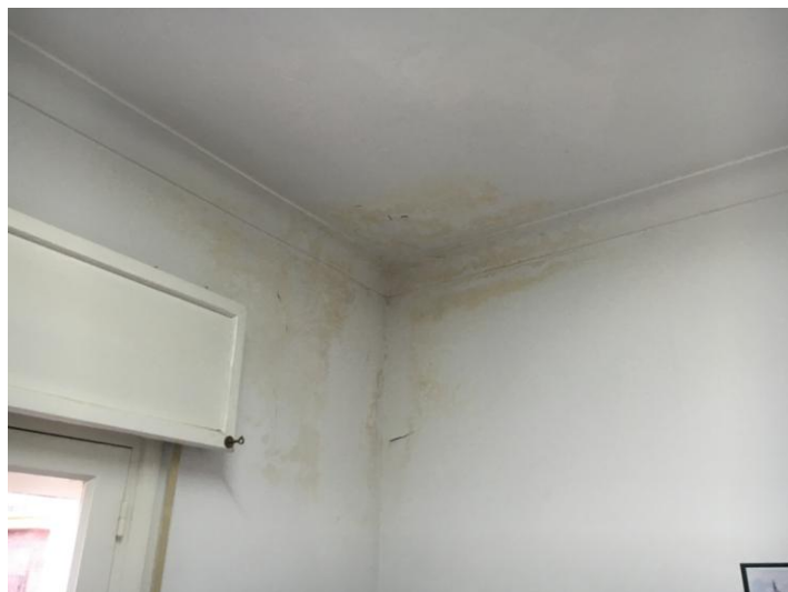
IMAGEN OFICINA ADMINISTRATIVOS PLANTA BAJA
