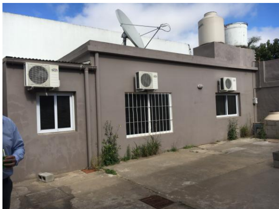
IMAGEN PATIO - PISO DE CEMENTO
