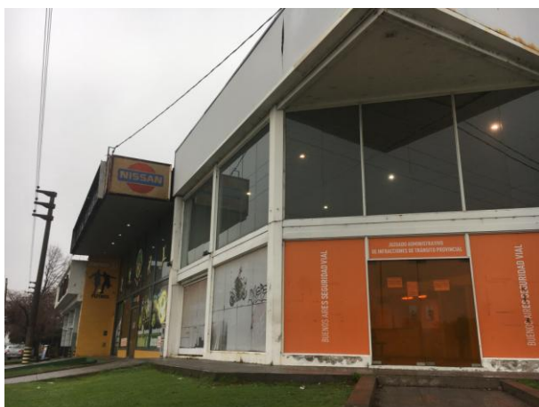
IMAGEN EXTERIOR FACHADA VIDRIADA
