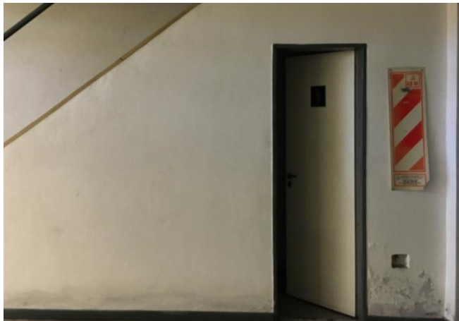
IMAGEN PUERTA PLACA EN BAÑO, COCINA Y OFICINAS.
