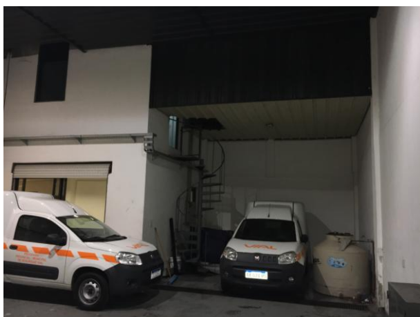
IMAGEN COCHERA PLANTA BAJA - PISO CEMENTO
