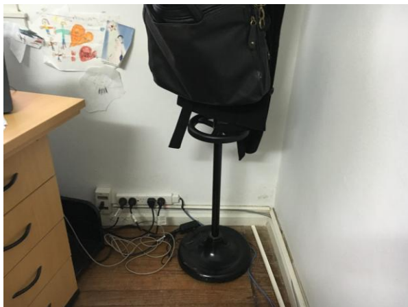
IMAGEN CABLES SUELTOS OFICINA ADMINISTRATIVA
