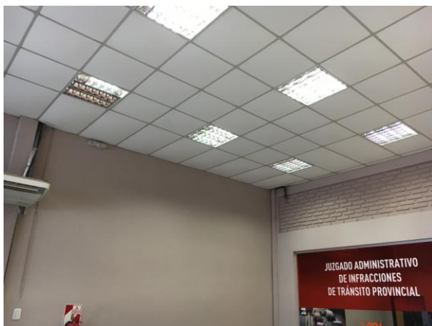
IMAGEN SALA DE ESPERA - CIELORRASO PANELES
