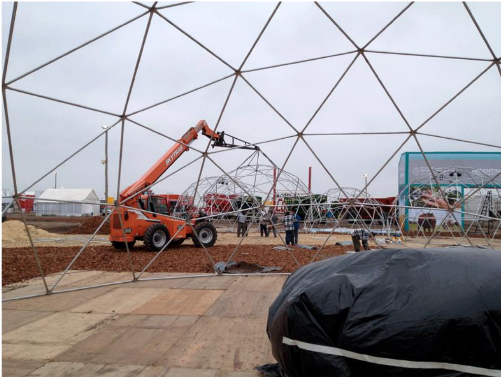
Armado con grúa de arriba hacia abajo
