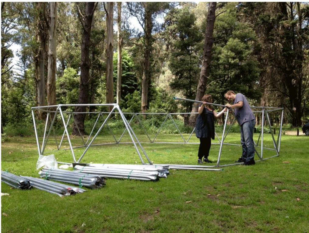
Armado de abajo hacia arriba en forma manual
