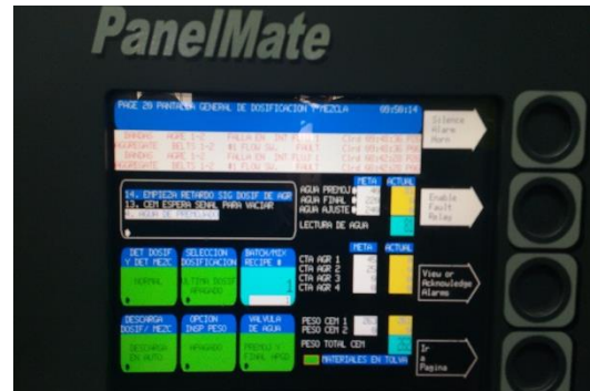
Ilustración 14 Panel de control de Estación Mezcladora.
