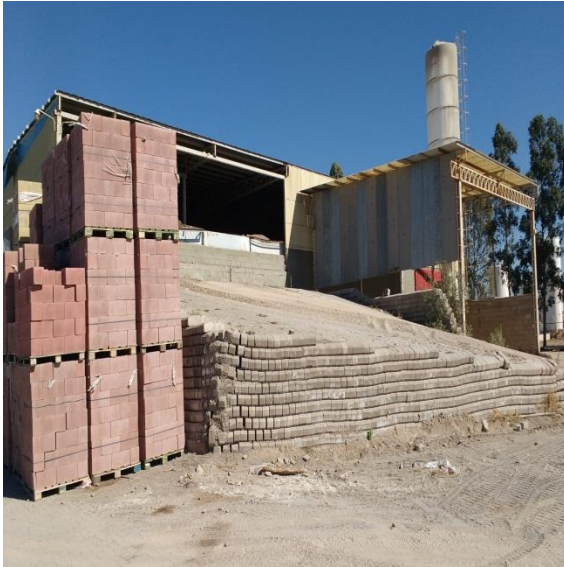
Ilustración 9 Rampa de acceso a Tolva.
