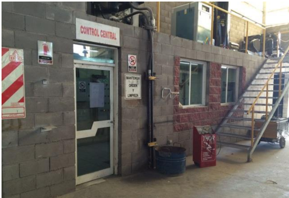
Ilustración 15 Acceso a Control Central y Sala de Servicios auxiliares.
