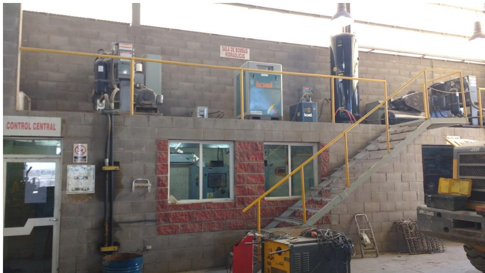
Ilustración 27 Acceso a Sala de Servicios Auxiliares.
