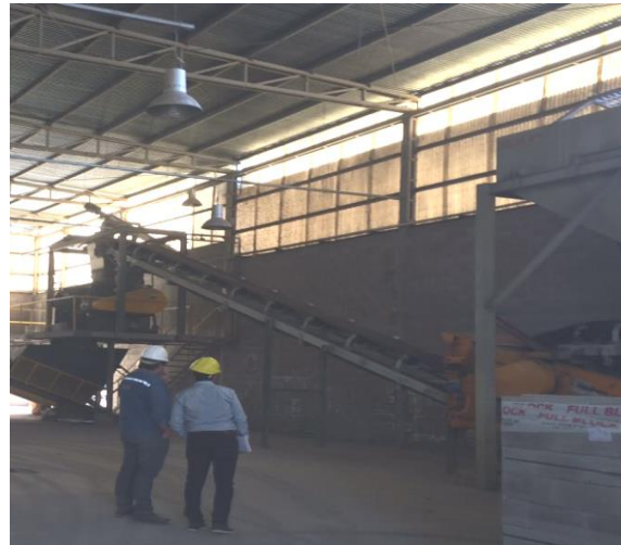
Ilustración 12 Cinta transportadora de Zaranda a Estación mezcladora.
