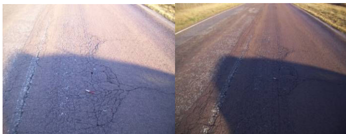
Figura 24: Estado superficial. Relevamiento propio
