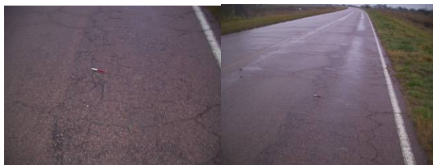
Figura 26: Estado superficial. Relevamiento propio
