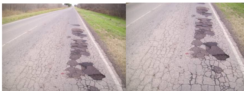
Figura 21: Estado superficial. Relevamiento propio
