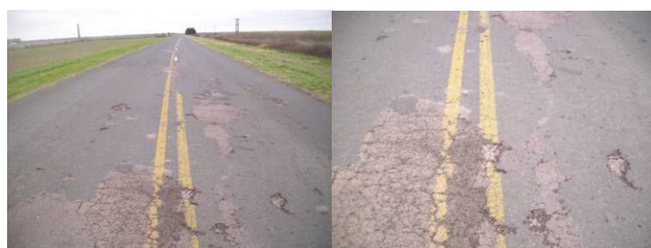
Figura 22: Estado superficial. Relevamiento propio
