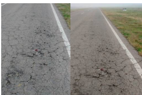
Figura 25: Estado superficial. Relevamiento propio
