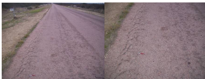
Figura 20: Estado superficial. Relevamiento propio
