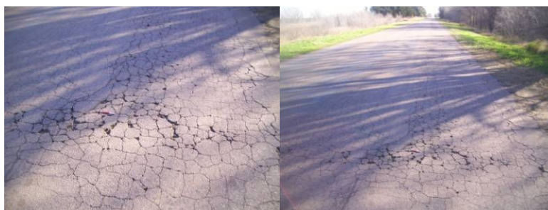
Figura 23: Estado superficial. Relevamiento propio
