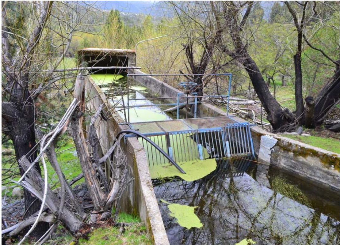
Ilustración 5: cámara de carga, rejas y vertedero
