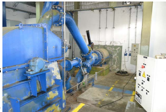
Ilustración 18: miniturbina con vista a válvula
