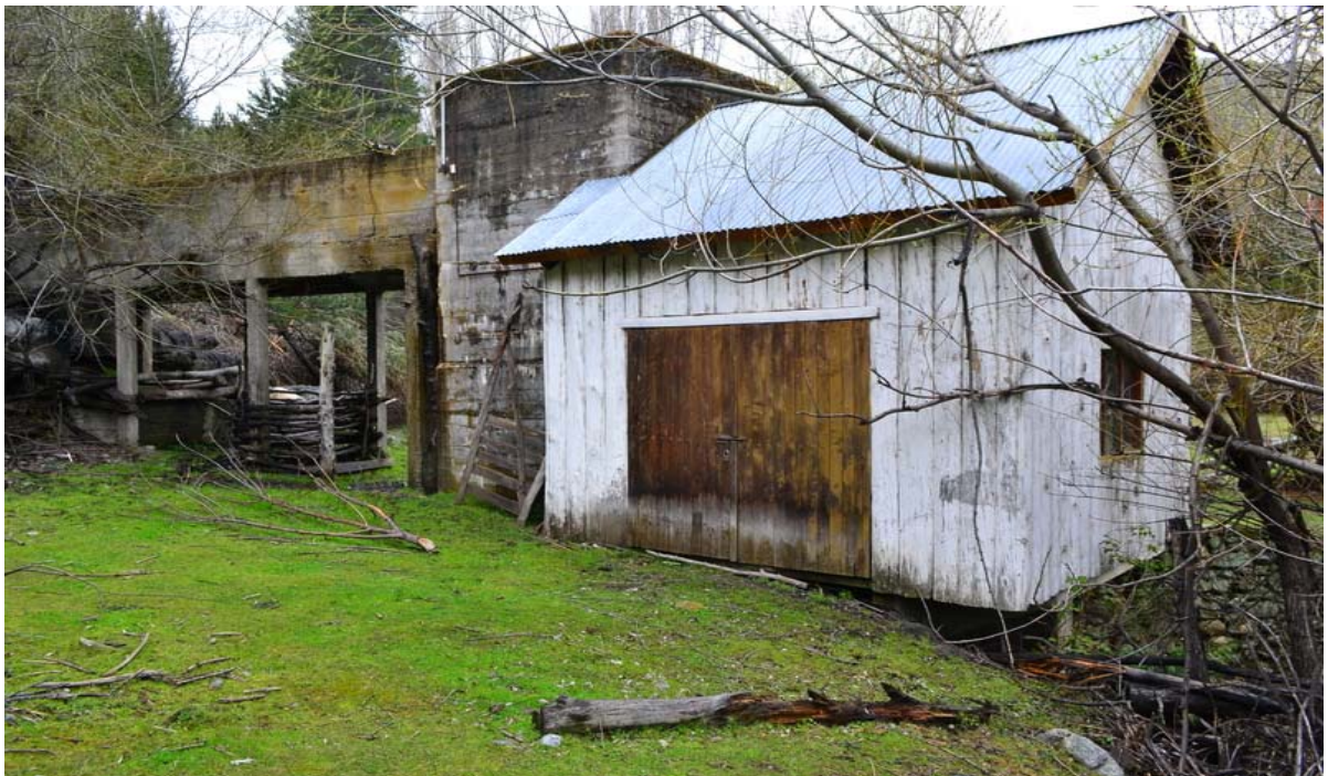
Ilustración 1: exterior sala de máquinas CH Cuesta del Ternero
