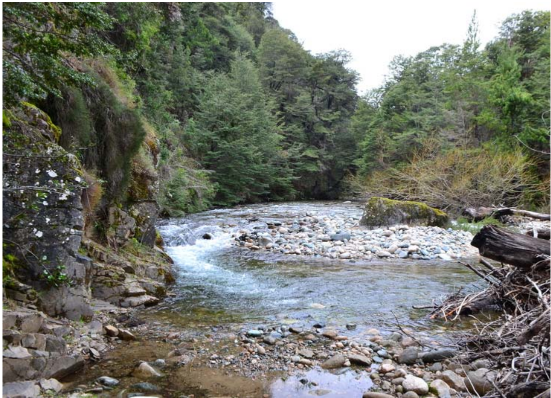
Ilustración 4: obra de toma destruida por crecidas
