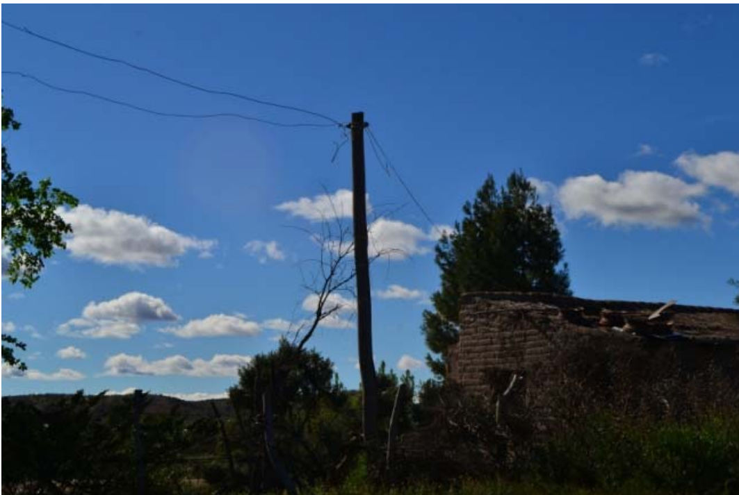
Ilustración 16: Ejemplo de bajada eléctrica residencial existente.
