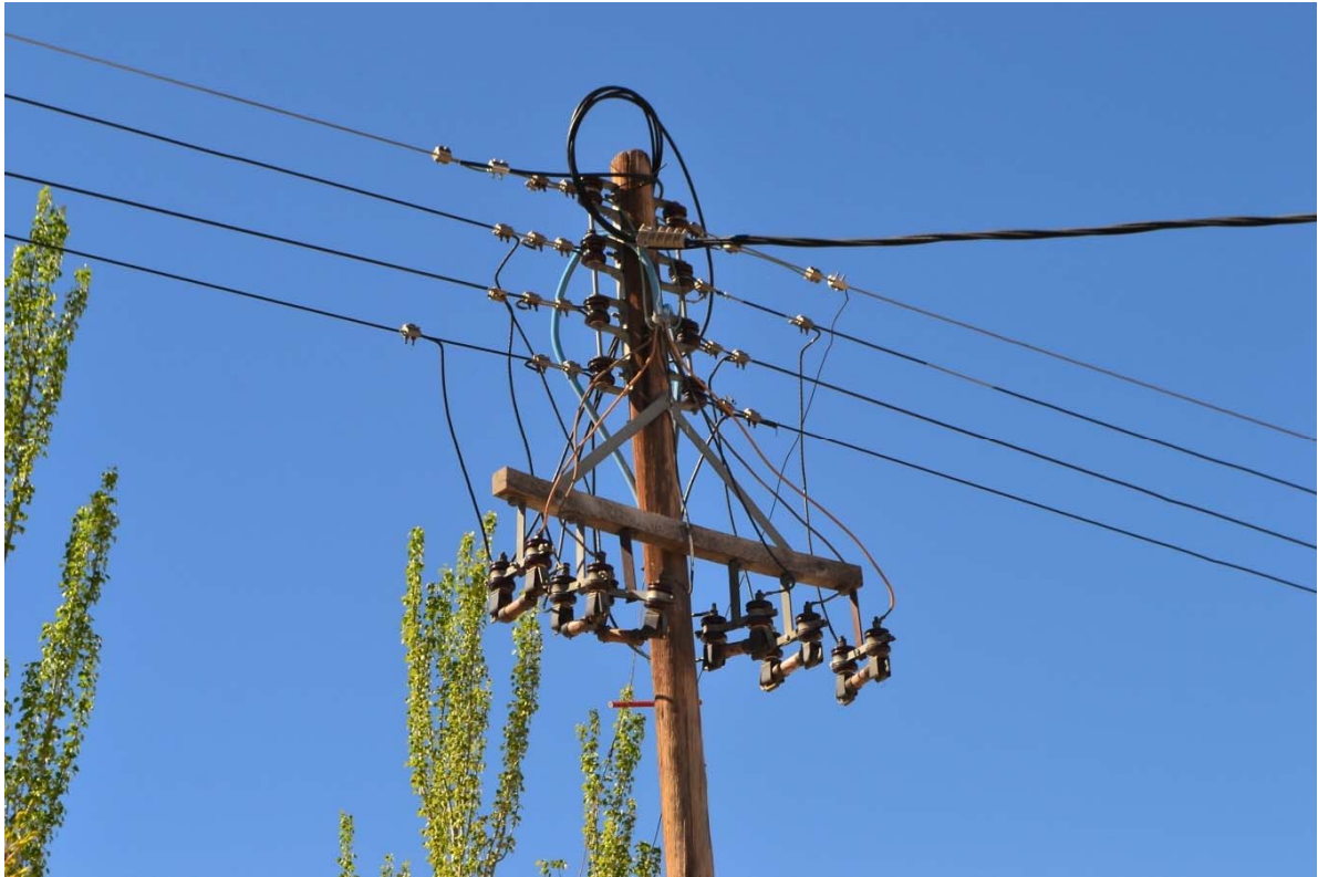
Ilustración 14: nodo de inyección y distribución principal.
