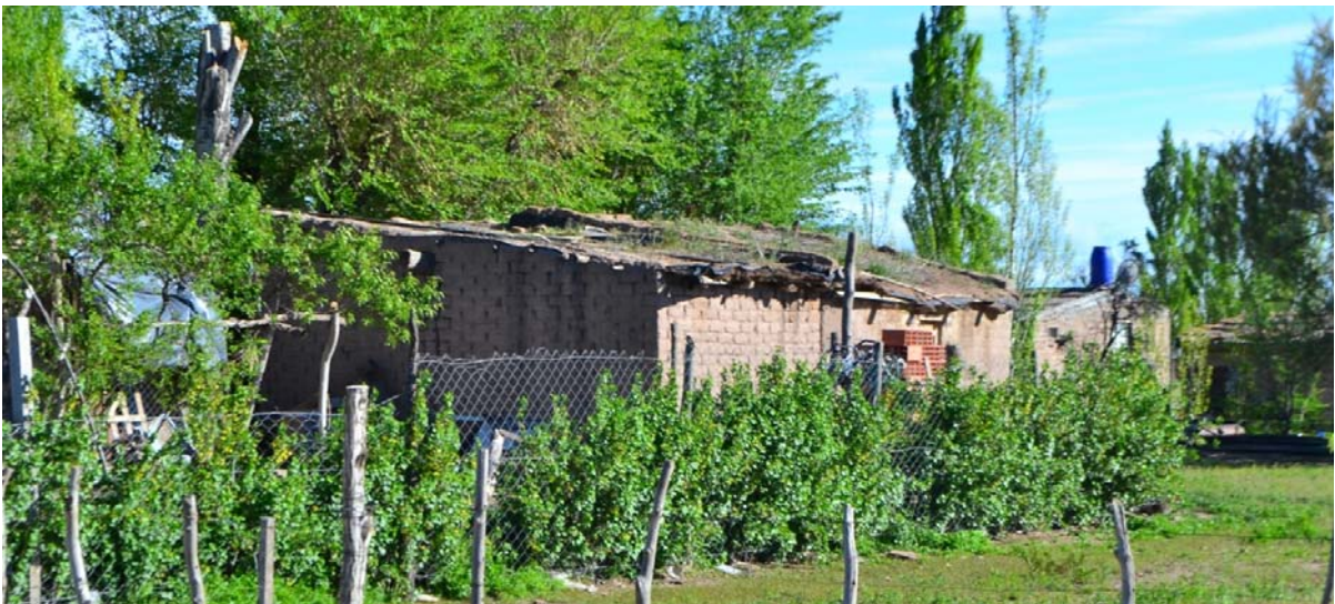
Ilustración 4: Construcción típica en adobe.
