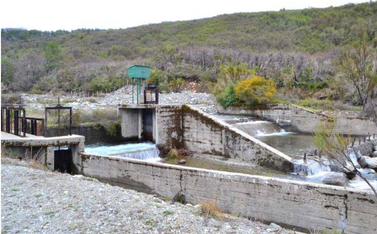
Ilustración 11: obra de captación sobre arroyo Pedregoso
