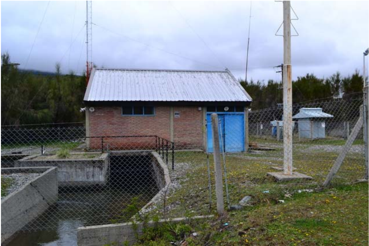
Ilustración 12: sala de máquinas CH1
