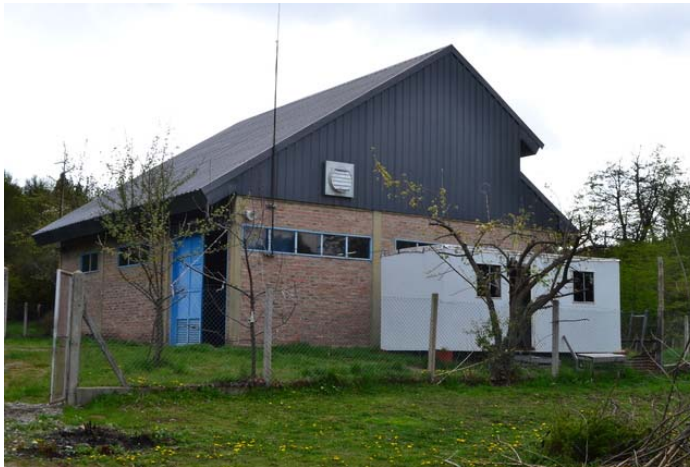
Ilustración 14: sala de máquinas CH2
