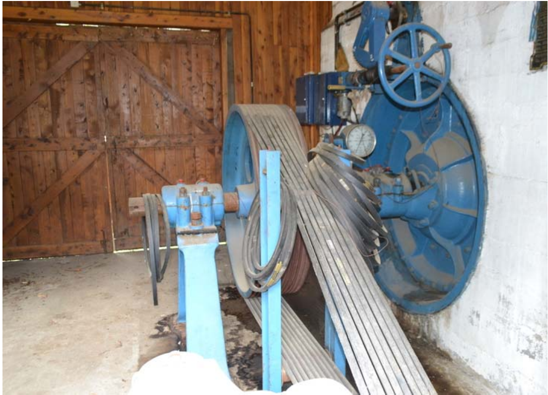
Ilustración 2: turbina hidráulica francés de cámara abierta
