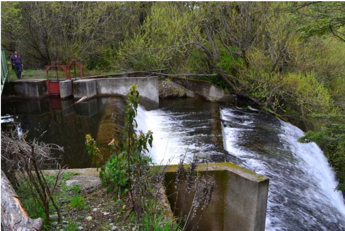
Ilustración 9: presa vertedero con toma lateral
