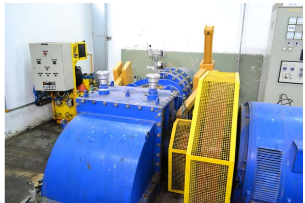
Ilustración 16: miniturbina con volante y generador
