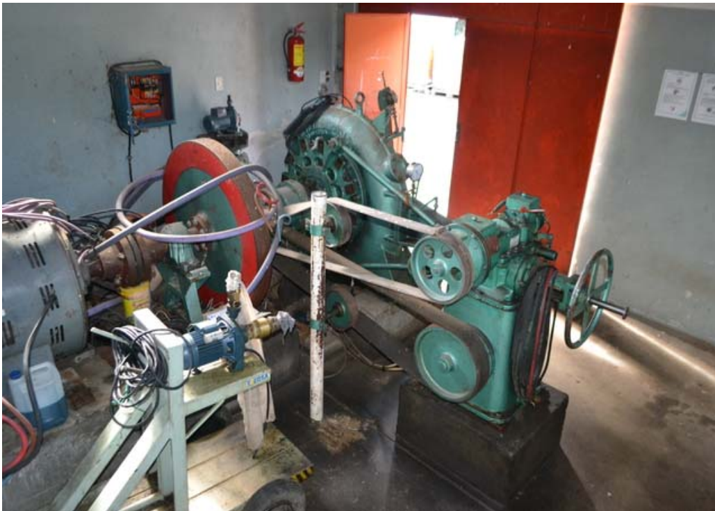
21: microturbina Francis Choi para uso aislado
