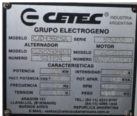
Ilustración 10: Placa de datos grupo generador diesel en operación actual.
