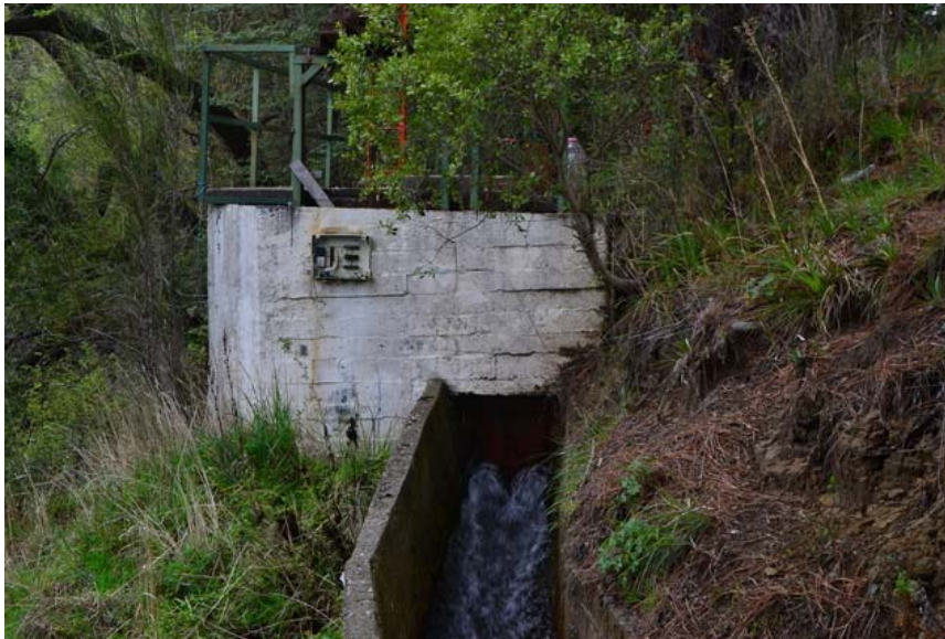
Ilustración 10: cámara de carga con salida de limpieza
