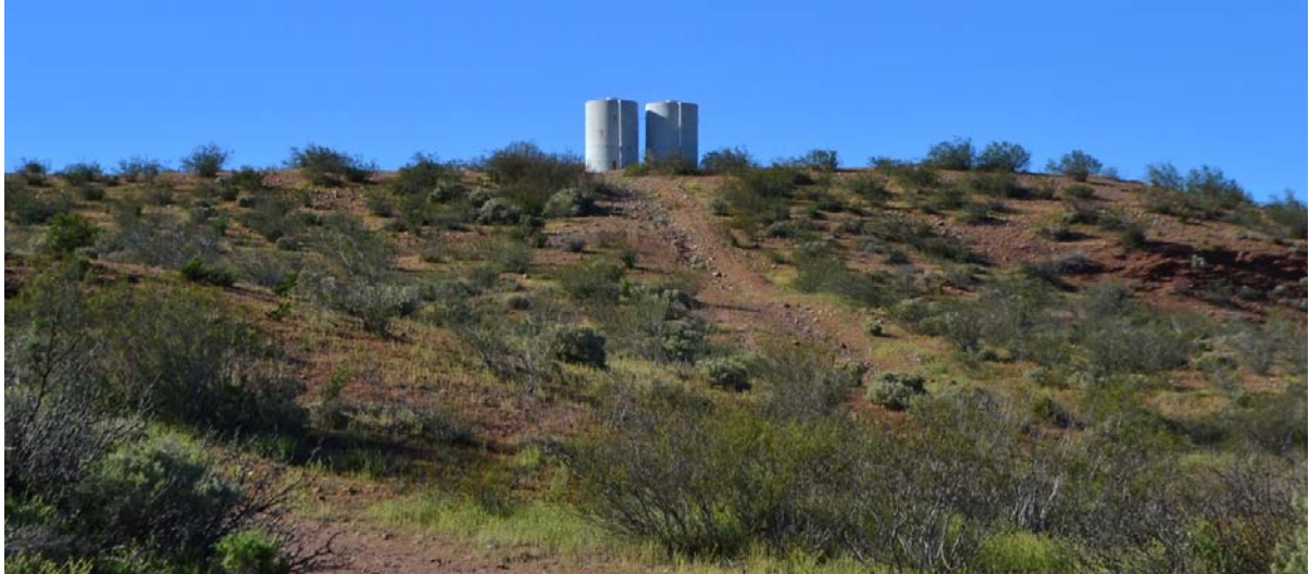
Ilustración 7: Tanques de almacenamiento de agua Naupahuén.
