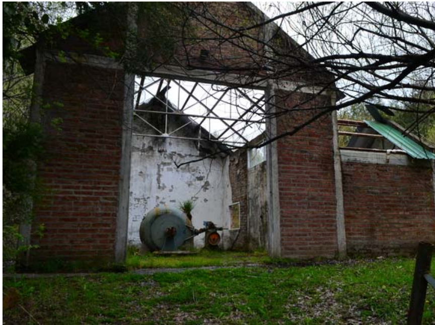
Ilustración 7: acceso a sala de máquinas hacia restitución a arroyo
