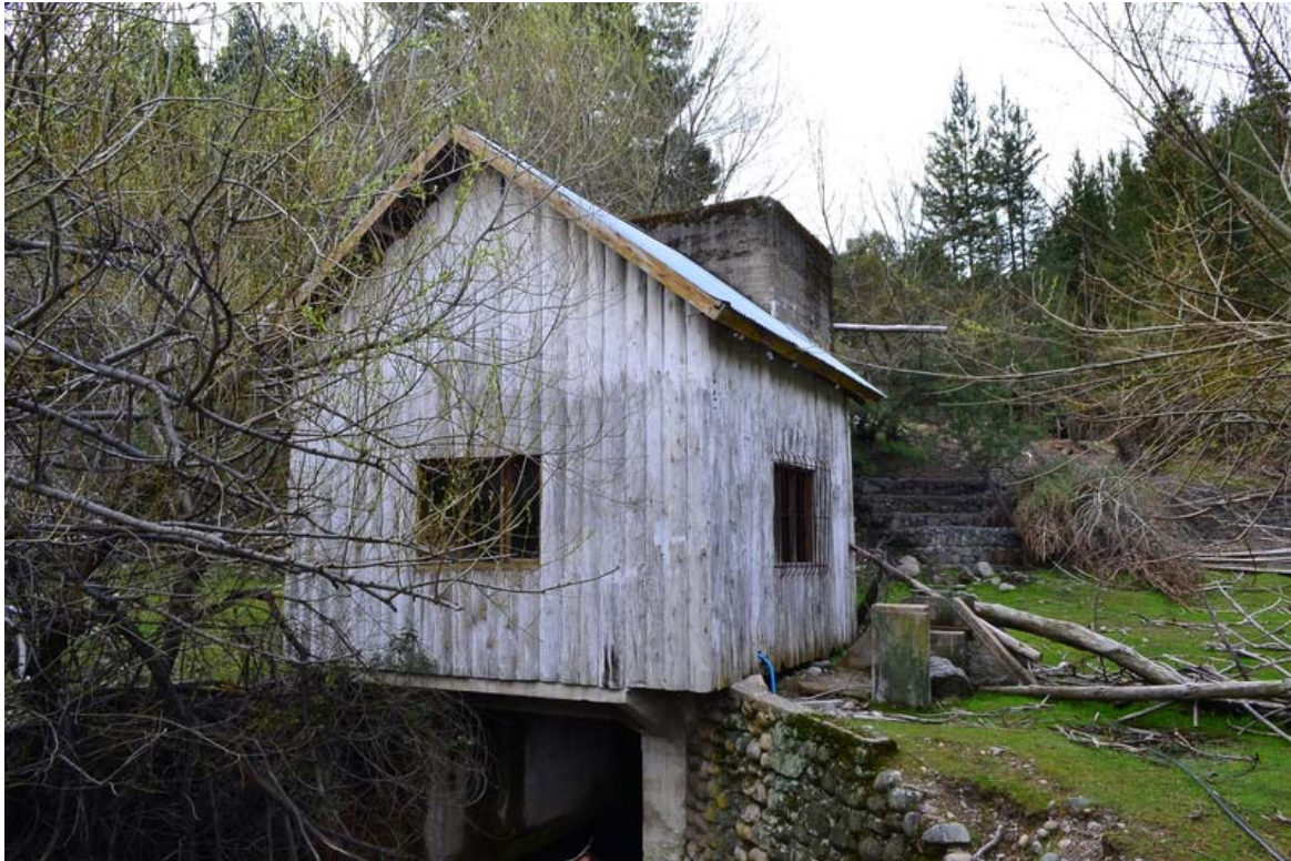
Ilustración 2: exterior sala de máquinas con vista de foso de descarga.
