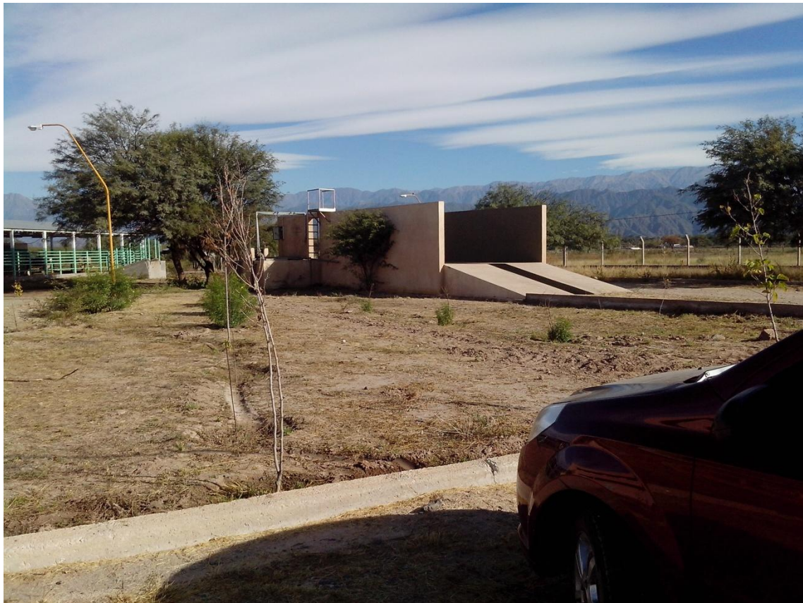
Cargadero Matadero de Belén
