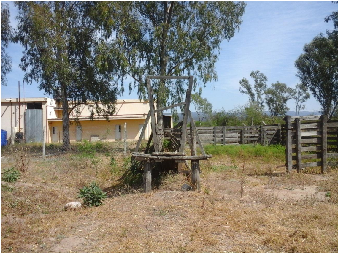
Cargadero Matadero de Alijilan
