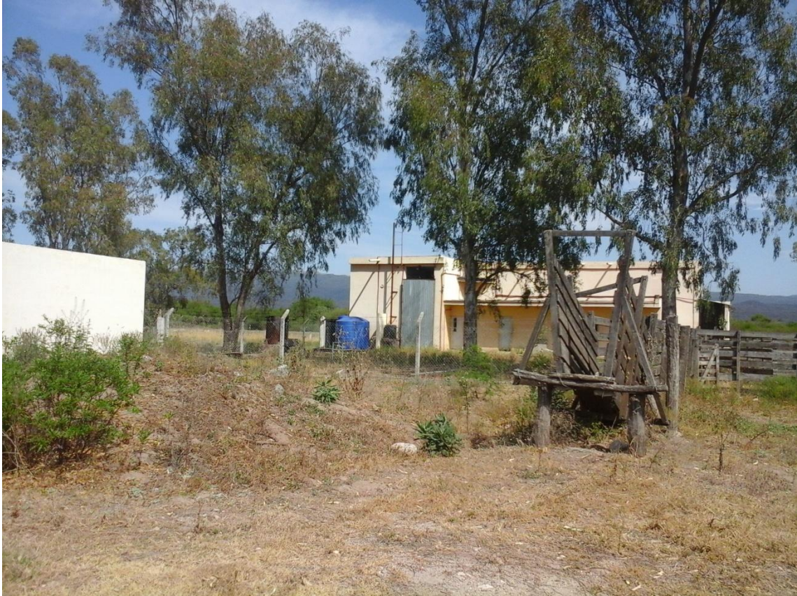
Cargadero Matadero de Alijilan
