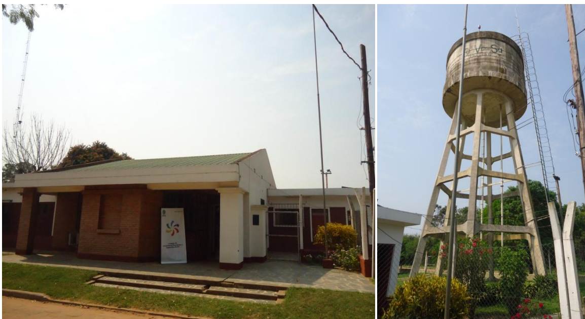
Fuente: fotografías propias de la visita (14/9/2012).
