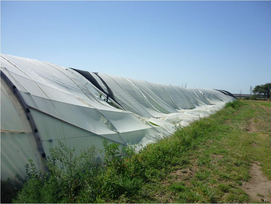
**Foto 5 y 6:** Macrotúnel con lateral totalmente aplastado por el viento.
