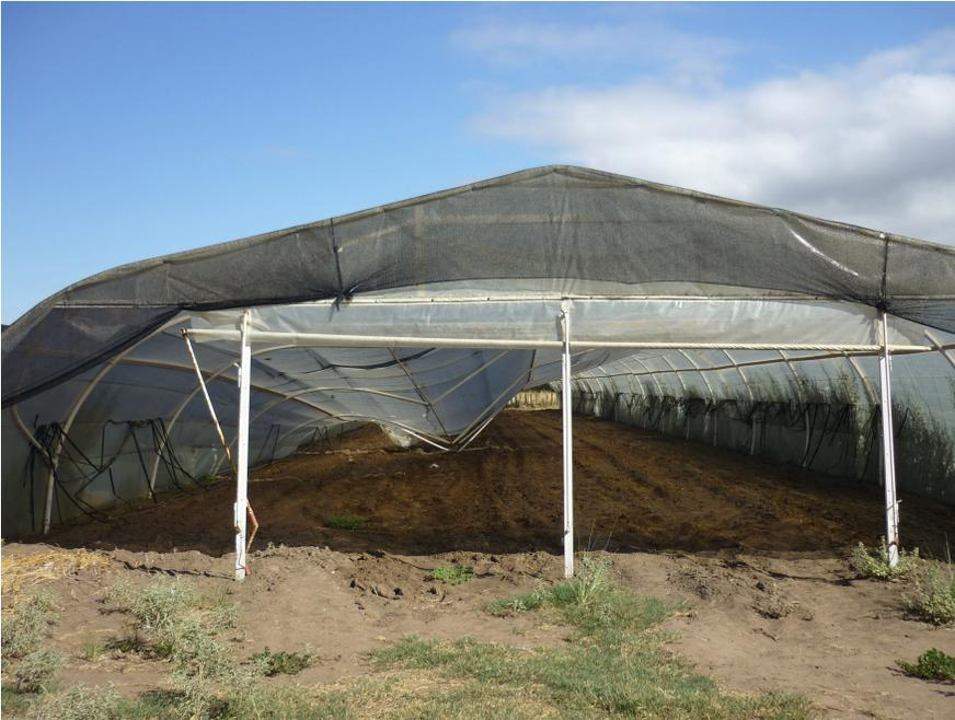
**Foto 2:** Invernadero alto para producción de tomate afectado por fuertes ráfagas de viento.
