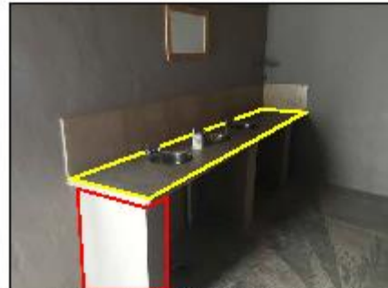
Se evidencia el deterioro de la pared posterior y la falta de mantenimiento de los trabajos plomeros, lo que indica que el agua se está acumulando en el piso en varias partes.
