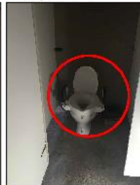
Se evidencia el deterioro de los trabajos plomeros, ya que se ve el agua en el piso, lo que indica que el agua se está acumulando en el piso en varias partes.
