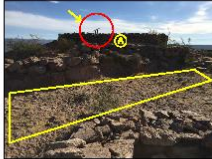
(A) Detalle de una de las unidades de mampostería, donde se observa el uso de piedras de diferentes tamaños, se resalta el uso de piedras de mayor tamaño en la construcción de los muros.
