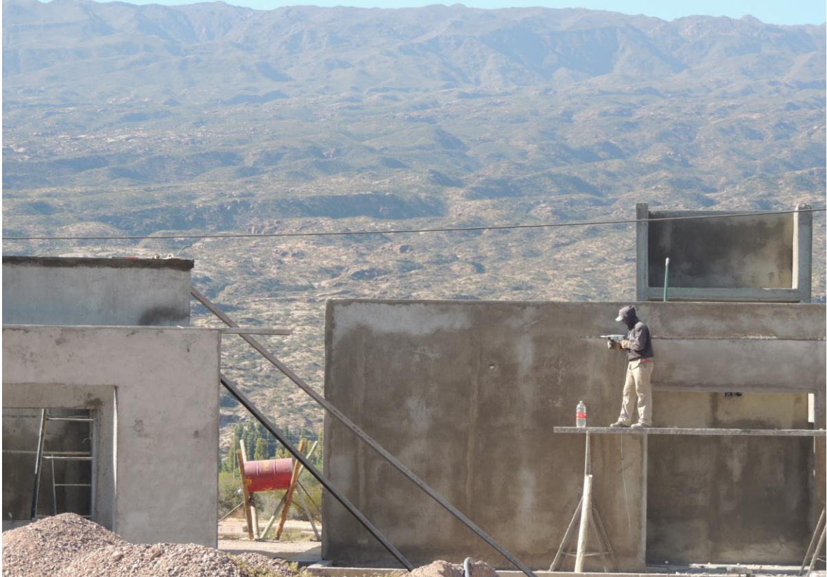
Hotel en construcción en localidad de Andolucas – Capacidad futura 63 camas
