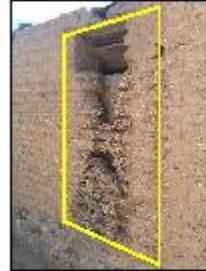
En esta foto, se evidencia un alabeo del sector posterior, por lo tanto de la pared del baño de señoras, debido a la falta de cobertura real en el caso de la canalización del baño de señoras.
