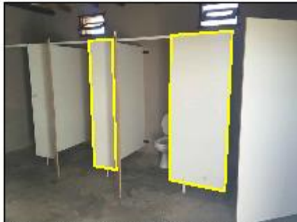
En este espacio se evidencia la falta de limpieza, además de la falta de mantenimiento, ya que se ve el agua en el piso, lo que indica que el agua se está acumulando en el piso en varias partes.
