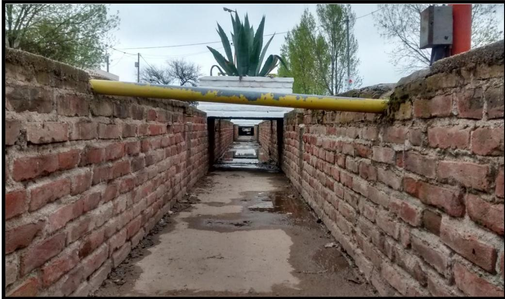
Fig. 32 Alcantarillas a cielo abierto
