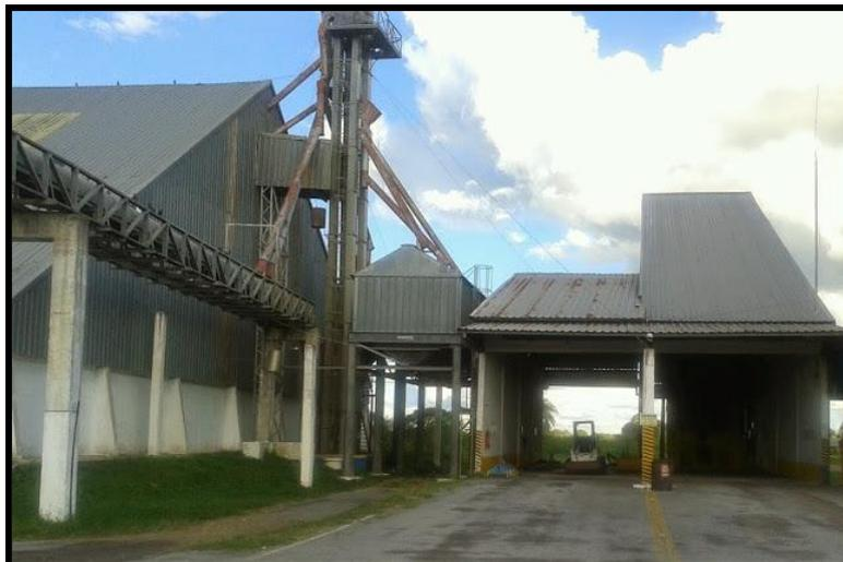
**Imagen 8. Silo para granos y Sistema de trasvasamiento y de ventilación**
