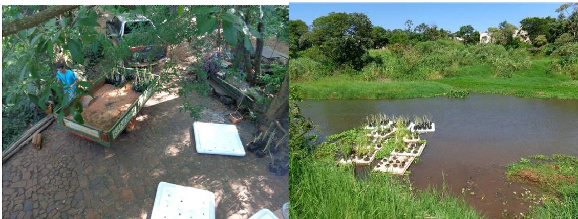
Reemplazando la estructura de tacuaras por otras más reforzadas construidas con caños sanitarios plásticos
