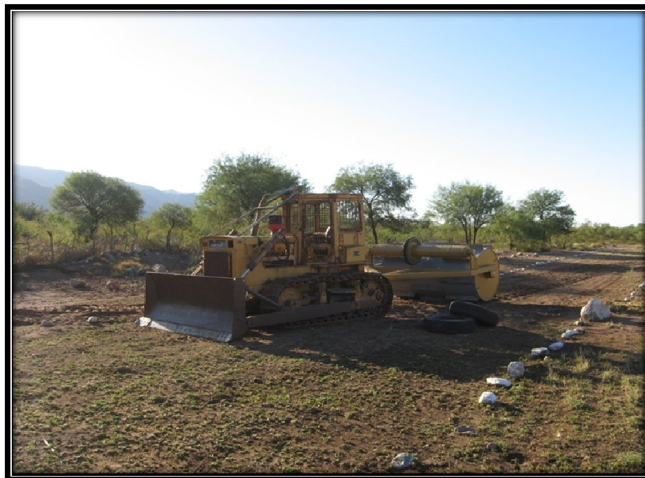
Topadora tipo D6 con rolo de 3 mts. ancho de trabajo
