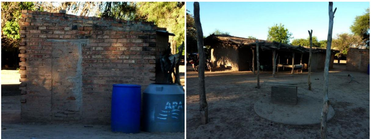
**Aljibe de la Familia Corvalan. En épocas de lluvia se coloca un plástico atado en los cuatro horcones con un agujero en el medio para recoger el agua. Se observa en la imagen de la derecha detalle de tanques de APA con “canaleta” para “cosechar agua”. Fotos: Edgar Noguera**
