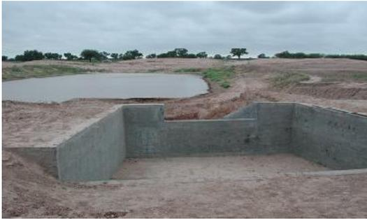
Decantador que retiene los sedimentos provenientes del área de captación e impide su ingreso a la represa.
