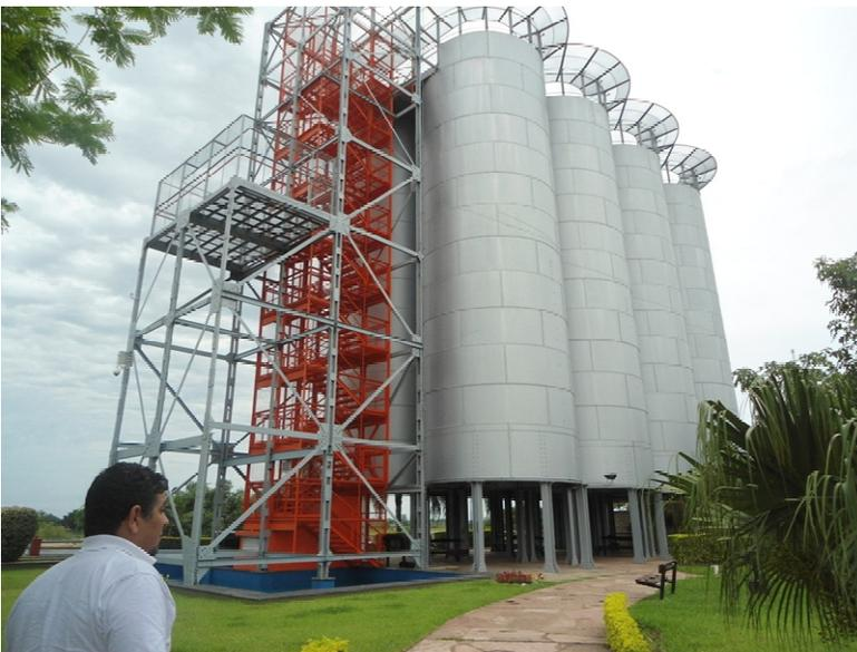
El acceso desde el suelo al mirador se efectiviza mediante una escalera de tramos rectos, completamente metálica.
