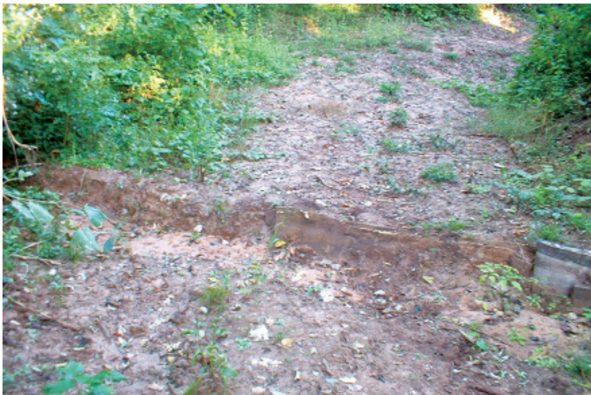
Medida preventiva mediante instalación de drenajes transversales, para evitar erosión (I. Sosa)
