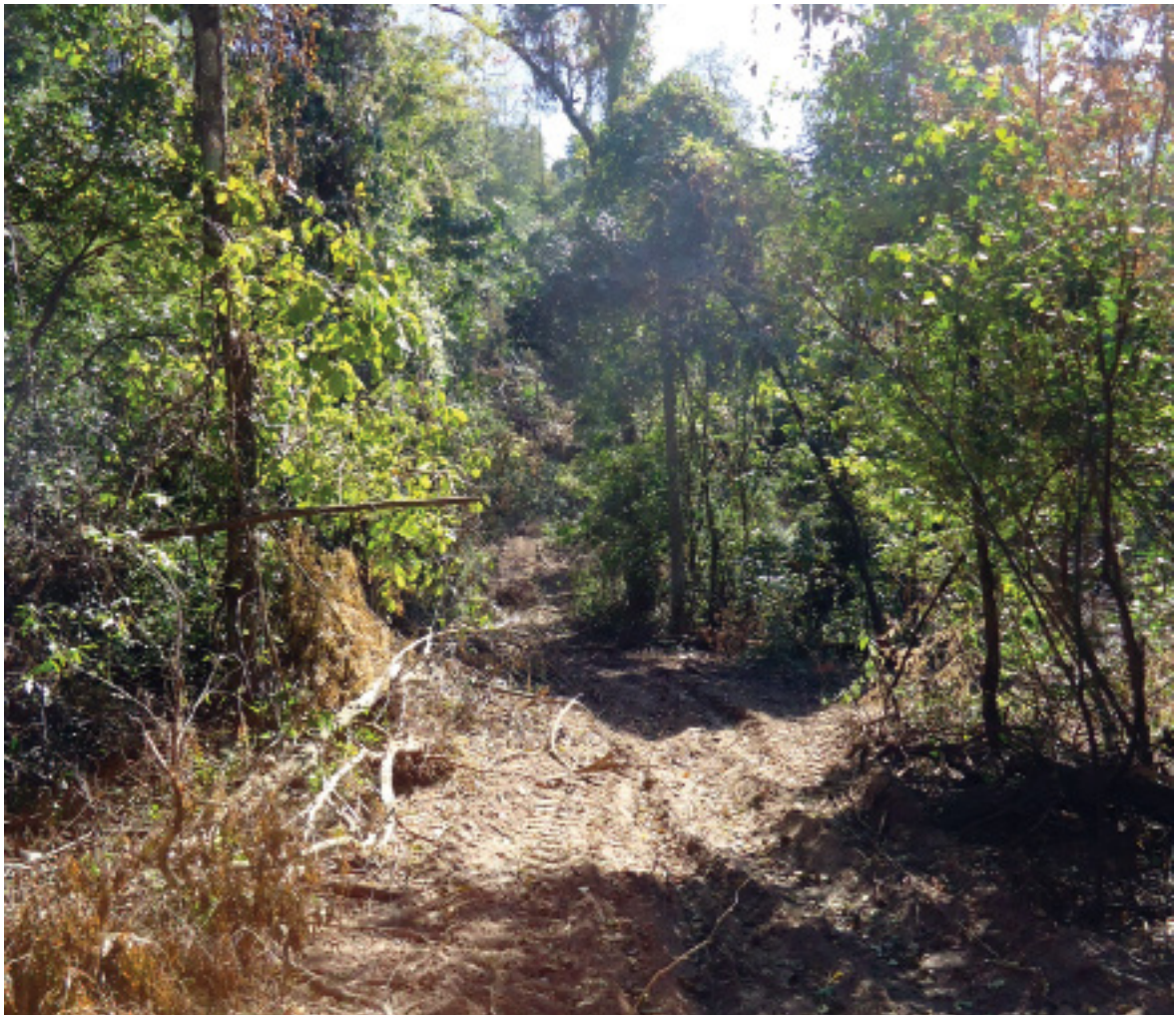
Erosión por caminos
