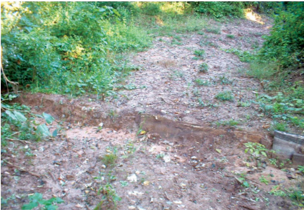
Drenajes transversales para evitar erosión (I. Sosa)
