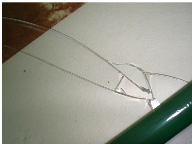
Rotura de vidrios e inestabilidad de enmarque.
