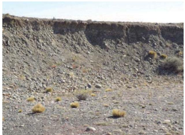
Figura 10. Vista de un corte aguas abajo del terraplén de la antigua ruta y alejado del río. Puede verse el predominio de rodados y el escaso espesor de suelos finos en la parte superior. (Fuente propia).
