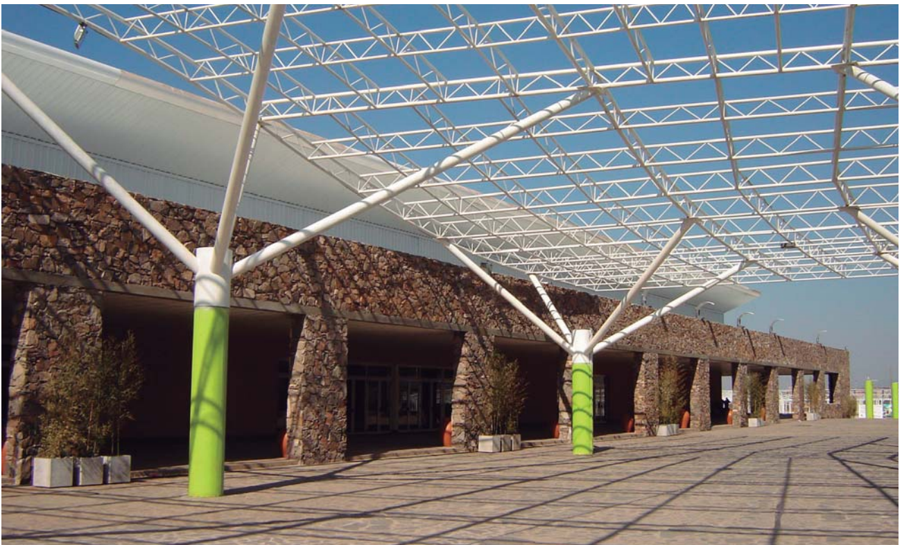
Flanqueada por galerías de paredes de piedra sobre las que se apoyan los grandes pabellones, la calle genera así una escala intermedia.
