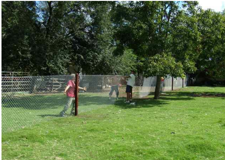
Foto 52: Alambrado perimetral para aislar animales
