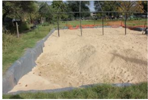
Foto 50: Acondicionamiento con arena y reposición de geotextil
