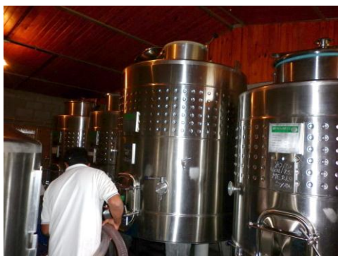
Bodega, tanques de acero inoxidable
