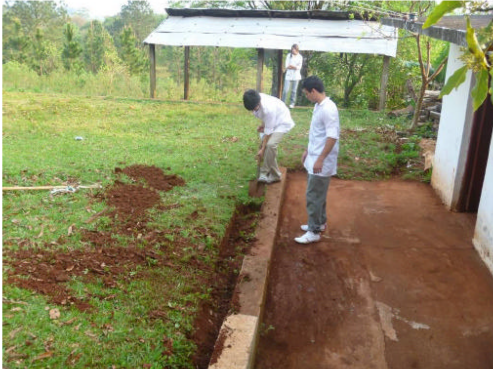
Alumnos del 3º polimodal arman una canaleta para el correcto drenaje de agua
