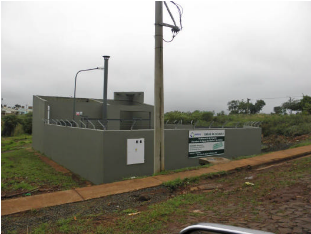
Estación debidamente reacondicionada y en funcionamiento
