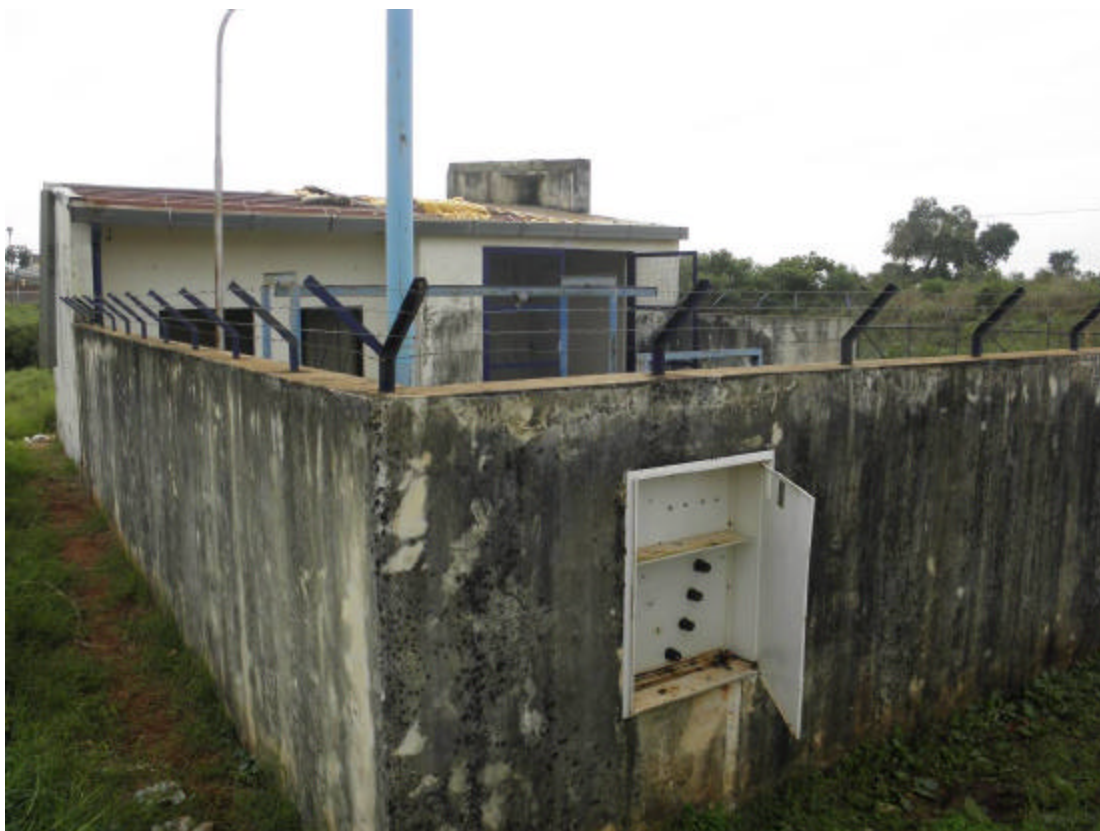
Estado inicial de la Estación elevadora de líquidos cloacales
