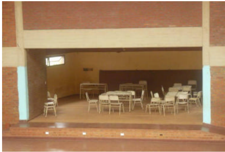
Vista del escenario de actos (antes de las tareas de pintura y refacción)
