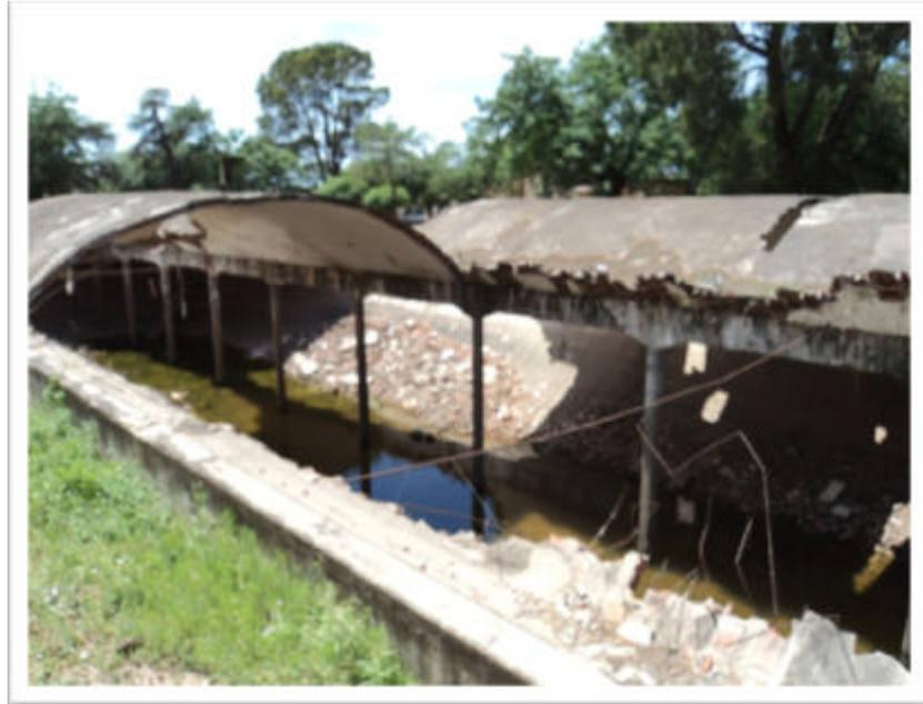
**Fotografía N° 1: Cisternas de almacenamiento en Campo Gallo, destinada a reparación (Proyecto)**
