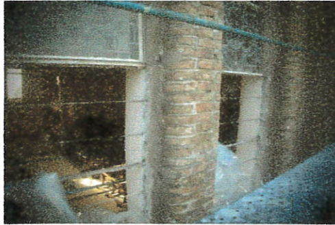
Rproceso de retiro de los paños que componen cada vitral.
