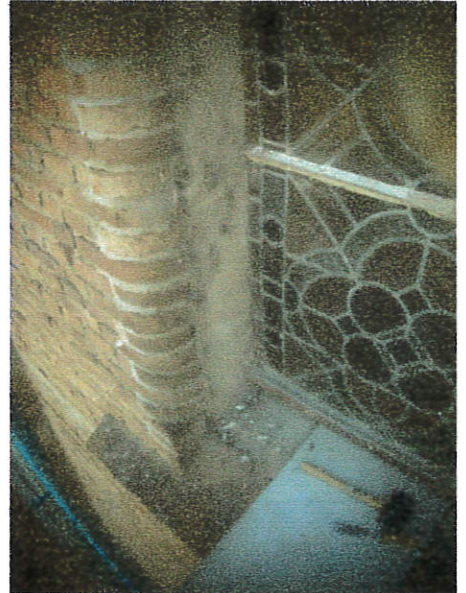
Rproceso de retiro de los paños que componen cada vitral.
