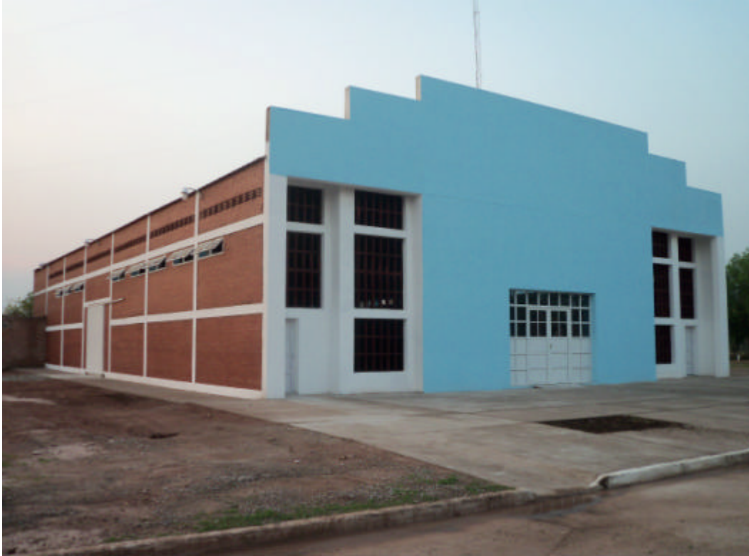
Polideportivo Municipal de taco Pozo
