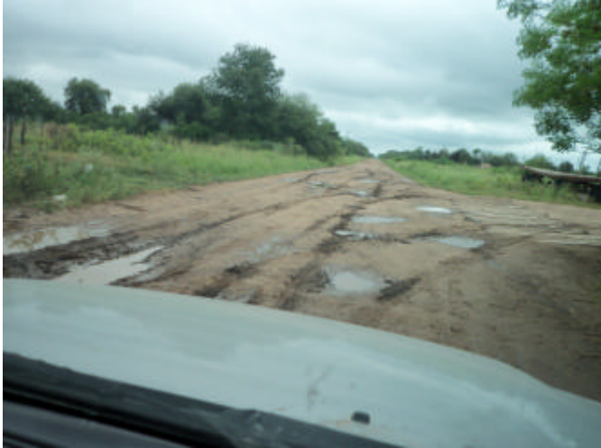
Camino anegado en Los Frentones
