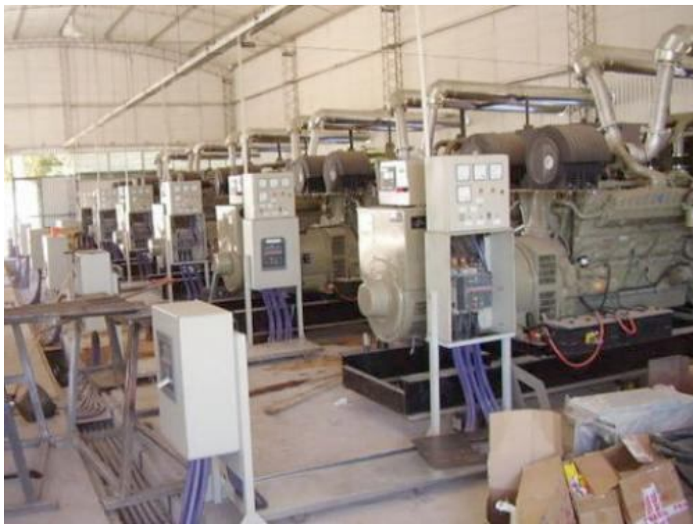
Figura N°3: Interior Central Térmica Santa Rosa. Generadores turbo diesel
