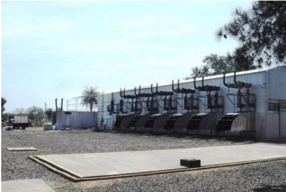
Figura N°2: Sistemas de escape de la Central Térmica Santa Rosa
