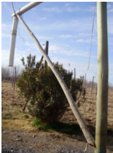
Zona de carga, caño que proviene de pozo de riego con bomba.
